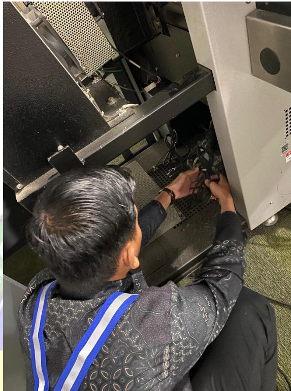
Gambar 3. 28 Mencabut Kabel Power Yang Terhubung Ke UPS Sumber : Dokumentasi penulis (2025)
