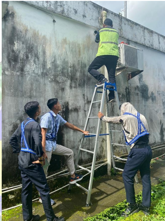
Gambar Lampiran 1 Perbaikan CCTV Kantor Devisi
