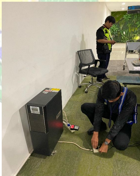
Gambar 3. 35 Menghubungkan kabel power monitor ke UPS utama
