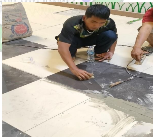
Gambar 4. 30 Pembersihan Sisa Material Sumber : Dokumentasi Pribadi, Tahun 2024
