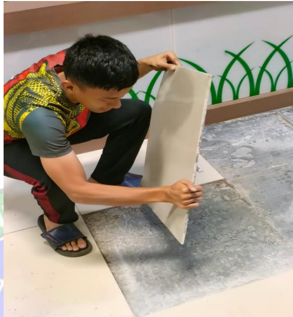
Gambar 4. 29 Pemasangan Keramik Baru Sumber : Dokumentasi Pribadi, Tahun 2024
