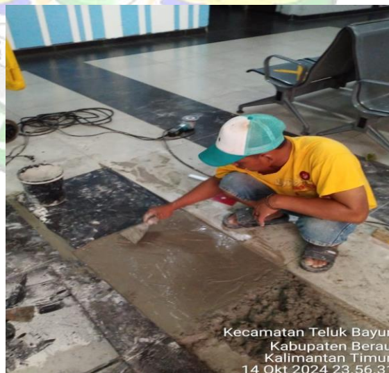
Gambar 4. 28 Pembuatan Lantai Kerja Sumber : Dokumentasi Pribadi, 2025
