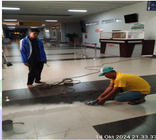
Gambar 4. 25 Pemotongan Nat Keramik Sumber : Dokumentasi Pribadi, 2024
