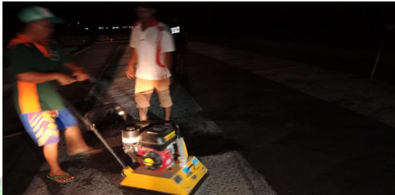
Gambar 4. 23 Pemadatan Menggunakan Stamper
