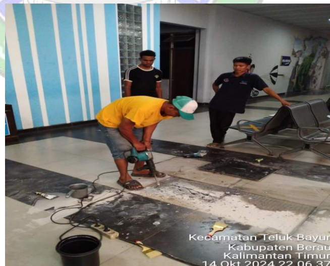
Gambar 4. 26 Pemahatan Lantai Kerja Sumber : Dokumentasi Pribadi, 2024
