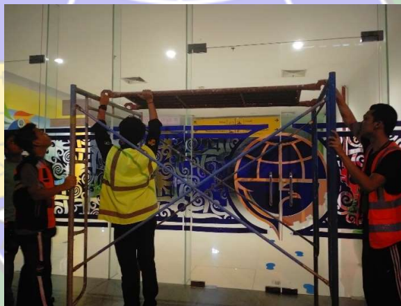
Gambar 4. 26 Proses Pemasangan Scaffolding (Sumber : Dokumentasi Penulis, 2024)
