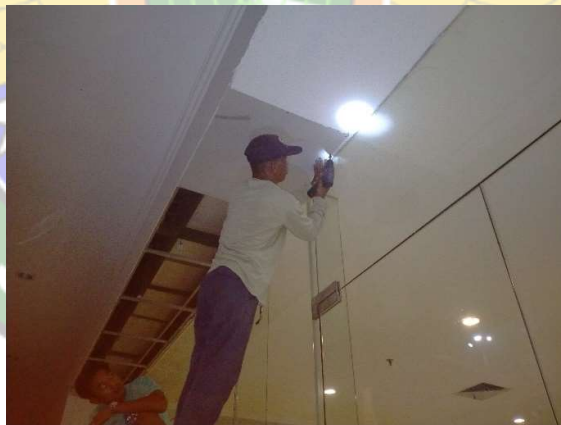
Gambar 4. 28 Pemasangan Lembaran Gypsum pada Rangka Plafon (Sumber : Dokumentasi Penulis, 2024)
