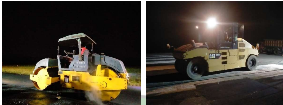
Gambar 4. 25 Proses Pemadatan menggunakan Tandem Roller dan PTR (Sumber : Dokumentasi Penulis, 2024)
