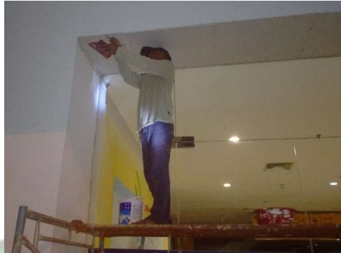
Gambar 4. 29 Pengaplikasian Compound Gypsum (Sumber : Dokumentasi Penulis, 2024)
