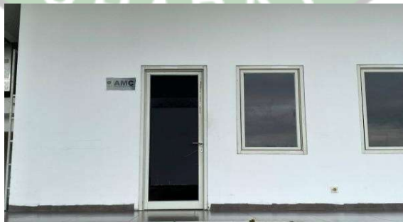
Gambar 4. 14 Apron Service (Sumber : Dokumentasi Penulis, 2024)
