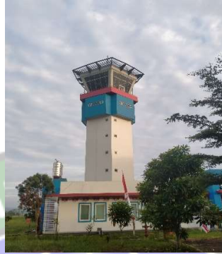
Gambar 4. 7 Bangunan Pengatur Lalu Lintas(ATC Tower) (Sumber : Dokumentasi Penulis, 2024)
