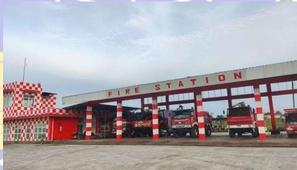
Gambar 4. 10 Bangunan PKP-PK (Sumber : Dokumentasi Penulis, 2024)
