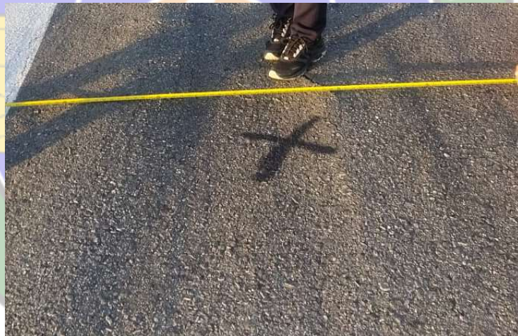
Gambar 3. 2 Kerusakan Rutting Pada Perkerasan Lentur (sumber : Dokumentasi penulis tahun, 2024)
