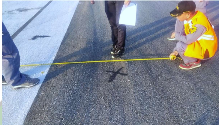
Gambar 4. 21 Kegiatan Pengukuran terhadap Kerusakan (Sumber : Dokumentasi Penulis, 2024)
