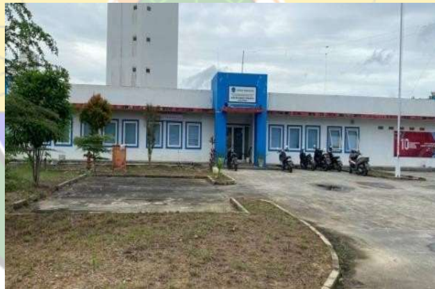
Gambar 4. 8 ATC Building (Office) (Sumber : Dokumentasi Penulis, 2024)
