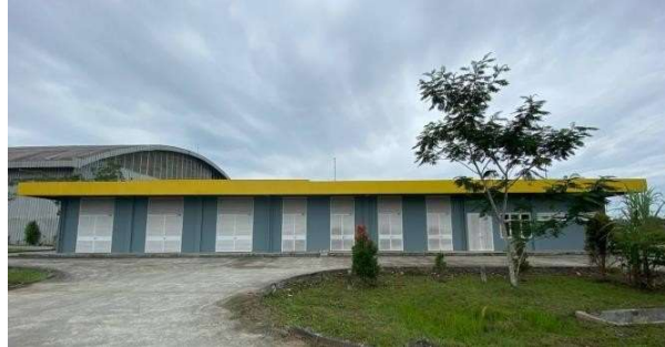
Gambar 4. 12 Gedung Power House (Sumber : Dokumentasi Penulis, 2024)
