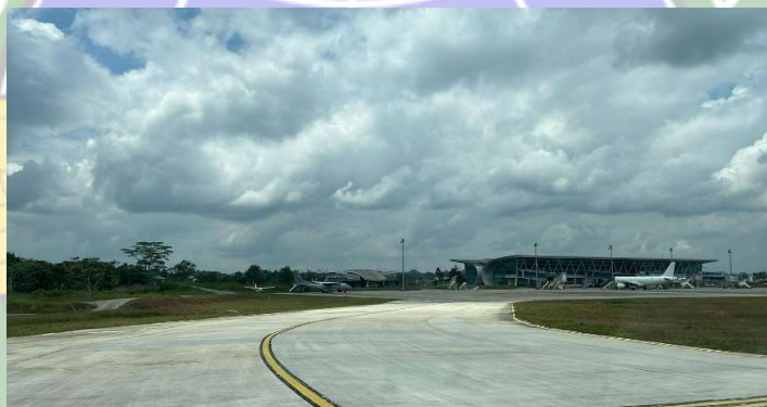
Gambar 4. 2 Landasan Hubung (Taxiway) (Sumber : Dokumentasi Penulis, 2024)
