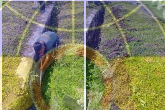
Gambar 4. 24 Pengangkatan sendimen dan sampah
