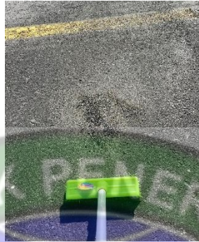
Gambar 4. 15 pembersihan area yang akan dicat
