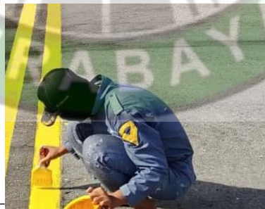
Gambar 4. 16 Pengecatan pada marka Runway Holding Position
