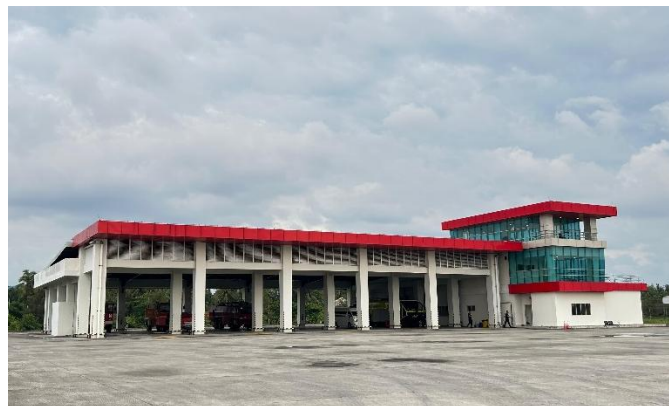
Gambar 4. 21 Sub Fire Station (Sumber : Dokumentasi Penulis,2024)
