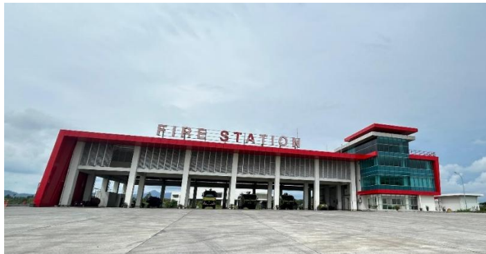
Gambar 4. 20 Main Fire Station (Sumber : Dokumentasi Penulis,2024)
