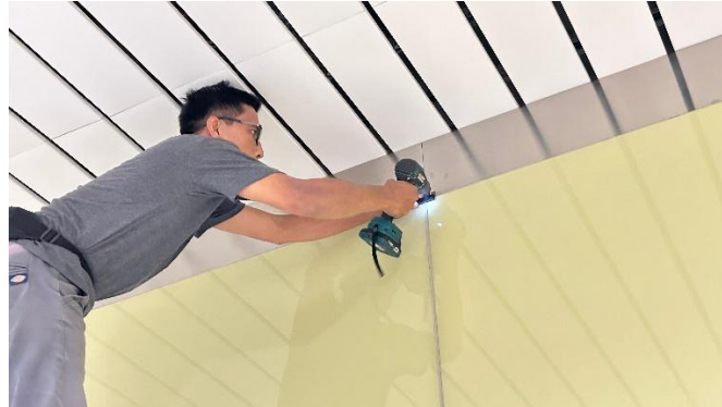
Gambar 4. 32 Pemasangan klem (Sumber : Dokumentasi Penulis,2024)
