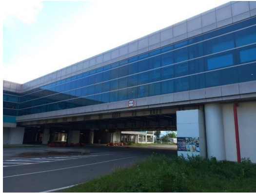
Gambar 4. 8 Terminal Penghubung (Sumber : Dokumentasi Penulis, 2024)
