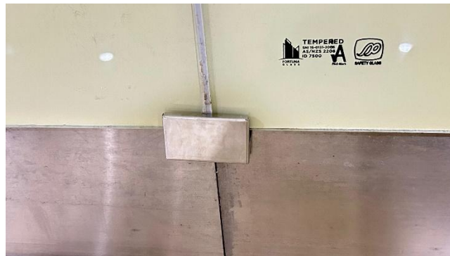
Gambar 4. 33 Pengecekan klem (Sumber : Dokumentasi Penulis, 2024)
