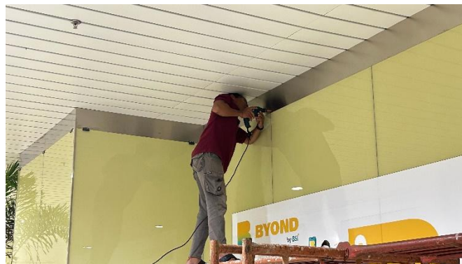
Gambar 4. 31 Pengeboran lubang menggunakan bor (Sumber : Dokumentasi Penulis, 2024)
