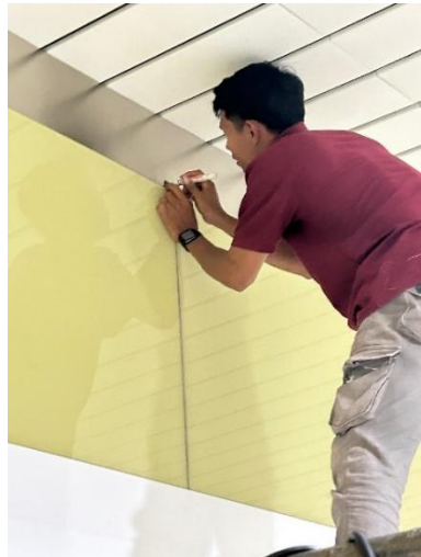
Gambar 4. 30 Penandaan titik klem menggunakan spidol (Sumber : Dokumentasi Penulis, 2024)
