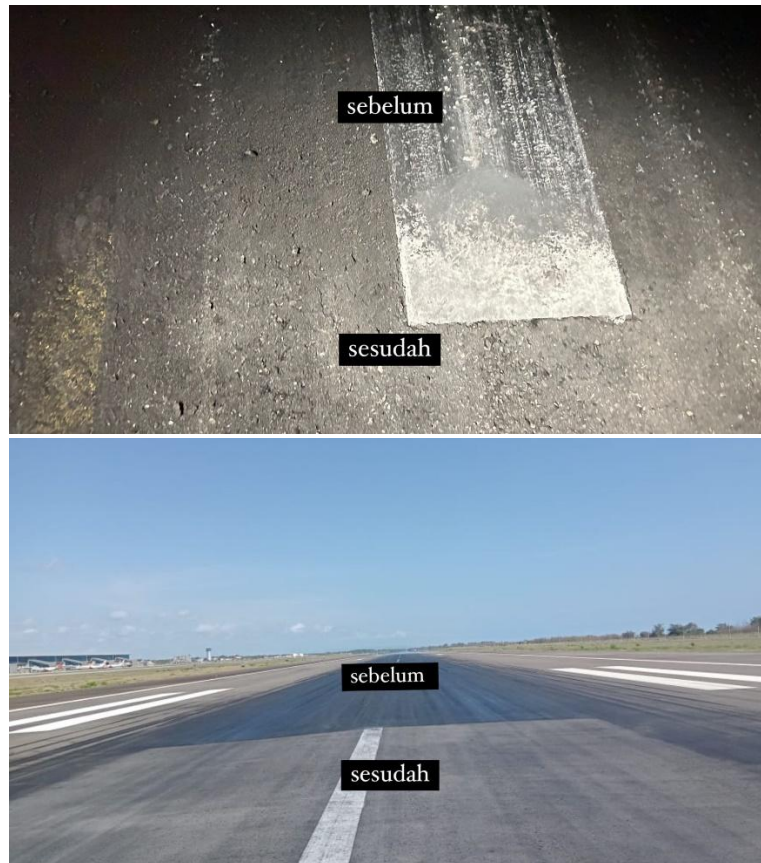
Gambar 4. 28 Hasil pembersihan rubber deposit (Sumber : Dokumentasi Penulis,2024)
