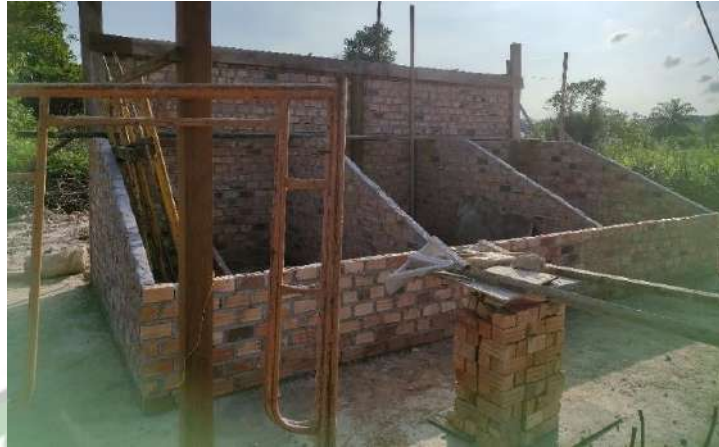
Gambar 4. 19 Pemasangan Bata Merah
