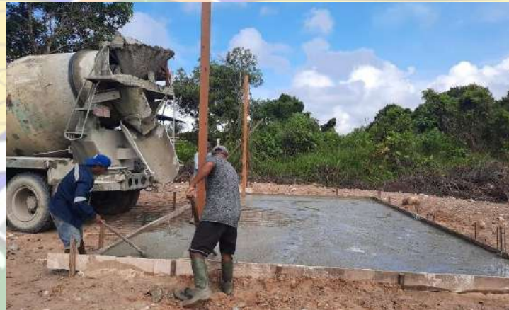
Gambar 4. 18 Pekerjaan pengecoran
