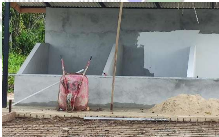
Gambar 4. 20 Pekerjaan Plesteran dan Plamir
