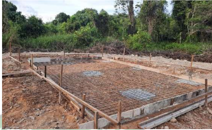
Gambar 4. 17 Pekerjaan Bekisting
