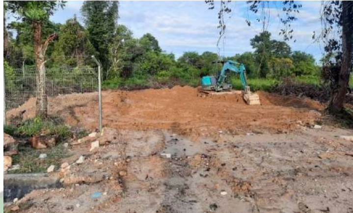
Gambar 4. 14 Pekerjaan penimbunan dan perataan
