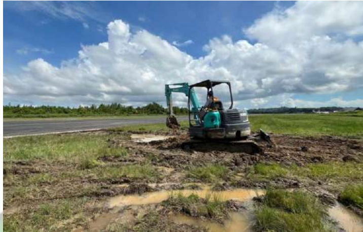
Gambar 4. 4 Perataan menggunakan excavator
