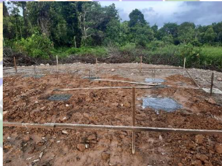
Gambar 4. 15 Pekerjaan Bowplank
