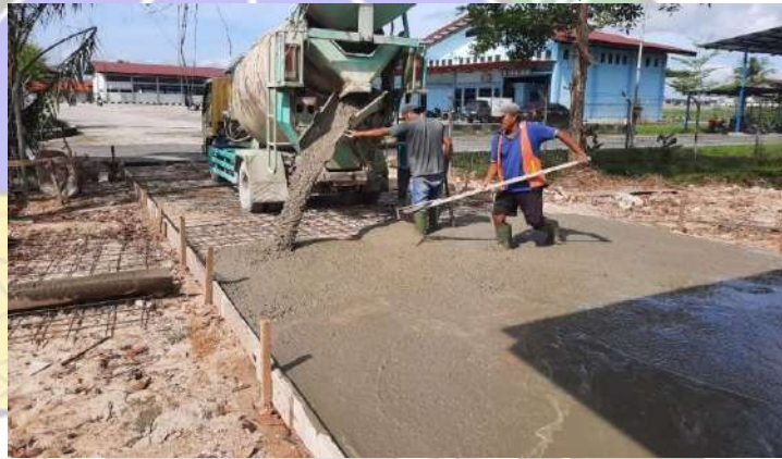
Gambar 4. 23 Pekerjaan Pengecoran
