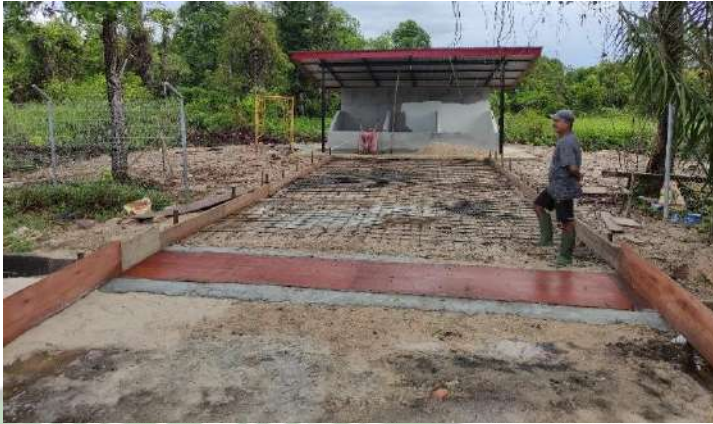
Gambar 4. 22 Pekerjaan Pembesian dan Pasang Bekisting
