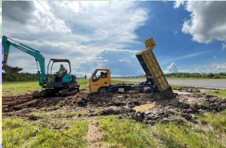
Gambar 4. 3 Pengangkutan tanah menggunakan Dump truck
