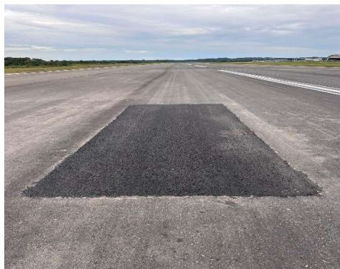
Gambar 4. 29 Hasil Pelaksanaan Pekerjaan Patching
