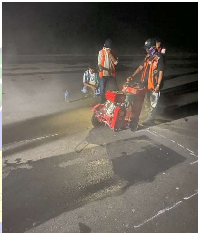
Gambar 4. 25 Proses Pemotongan Permukaan Eksisting (Sumber : Dokumentasi Penulis, 2025)
