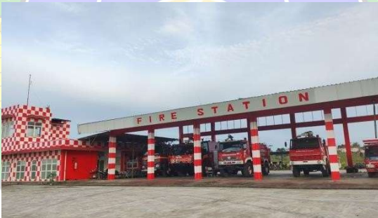
Gambar 4. 10 Bangunan PKP-PK (Sumber : Dokumentasi Penulis, 2024)
