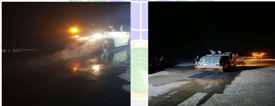
Gambar 4. 28 Proses Pemadatan menggunakan Tandem Roller dan PTR (Sumber : Dokumentasi Penulis, 2025)
