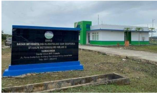
Gambar 4. 9 Bangunan Meteorologi (BMKG) (Sumber : Dokumentasi Penulis, 2024)
