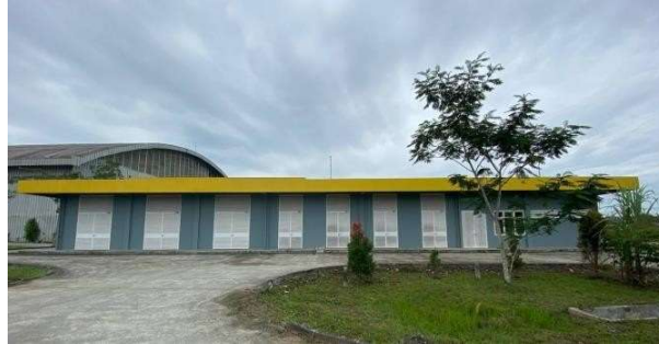
Gambar 4. 12 Gedung Power House (Sumber : Dokumentasi Penulis, 2024)
