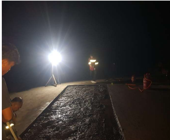
Gambar 4. 26 Proses Pemberian Tack Coat (Sumber : Dokumentasi Penulis, 2025)
