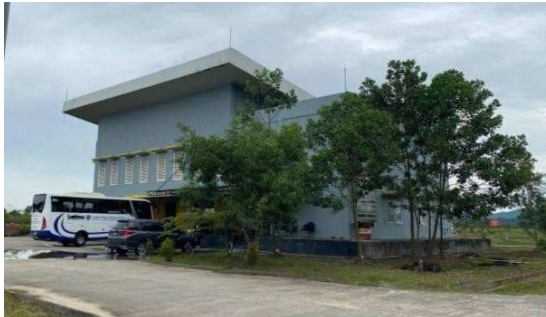
Gambar 4. 16 Gedung A2B (Sumber : Dokumentasi Penulis, 2024)
