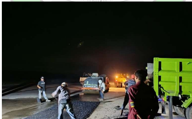
Gambar 4. 27 Proses Penghamparan Asphalt Hotmix (Sumber : Dokumentasi Penulis, 2025)
