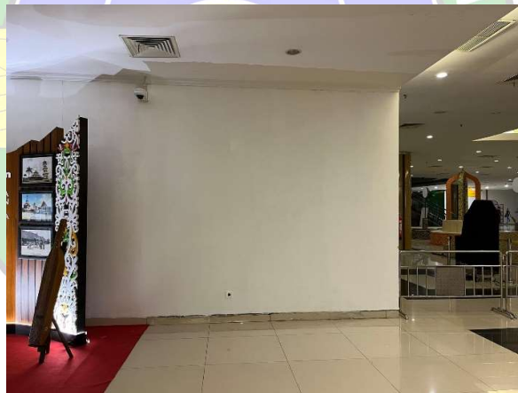
Gambar 4. 32 Hasil Pekerjaan Pengecatan
