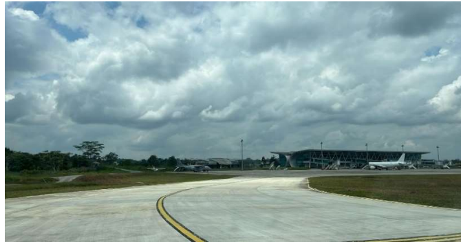
Gambar 4. 2 Landasan Hubung ( Taxiway ) (Sumber : Dokumentasi Penulis, 2024)
