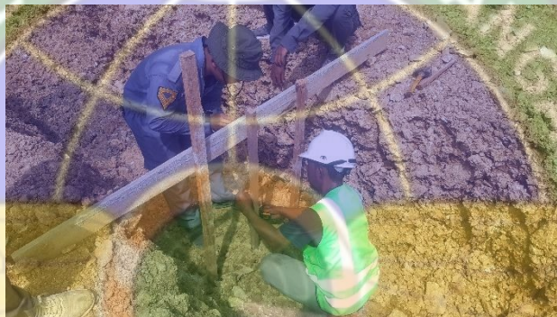
Gambar 4. 45 Pembuatan Bowlplank Drainase (Sumber : Dokumentasi Penulis, 2024)
