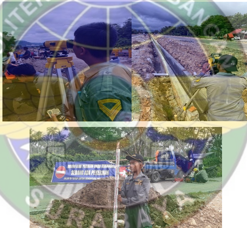
Gambar 4. 43 Pengukuran Elevasi dan Kelurusan Drainase (Sumber : Dokumentasi Penulis, 2024)
