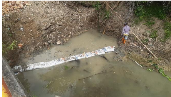
Gambar 4. 48 Pemasangan Sandbag (Sumber : Dokumentasi Penulis, 2024)
