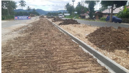
Gambar 4. 51 Penimbunan Tanah Gembur (Sumber : Dokumentasi Penulis, 2024)
