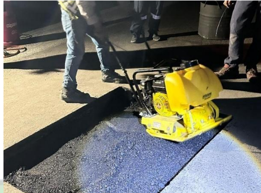
Gambar 4.26 Pemadatan Lapis Pertama (Sumber : Dokumentasi Penulis, 2024)
