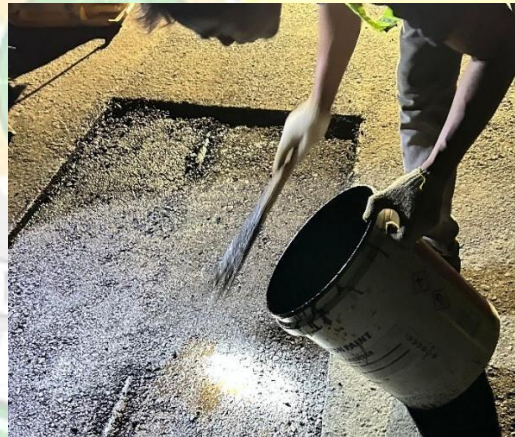
Gambar 4.27 Penuangan Emulsi Lapis Kedua (Sumber : Dokumentasi Penulis, 2024)
