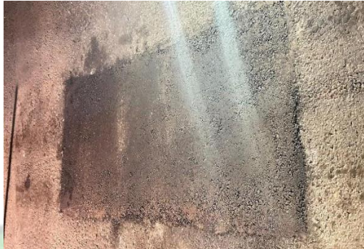
Gambar 4.30 Hasil Pekerjaan Patching (Sumber : Dokumentasi Penulis, 2024)
