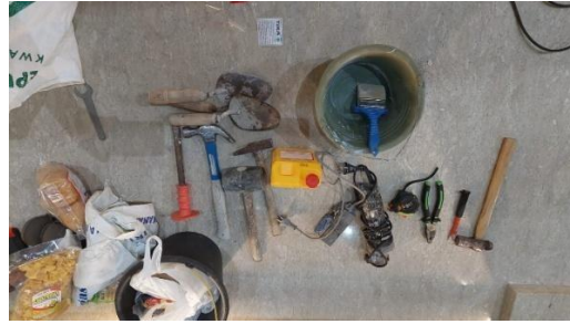
Gambar 4.31 Alat dan Bahan Perbaikan Lantai (Sumber : Dokumentasi Penulis, 2024)
