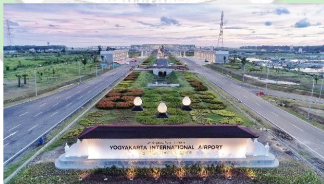
Gambar 2.1 Bandar Udara Internasional Yogyakarta (Sumber : Wikipedia)
