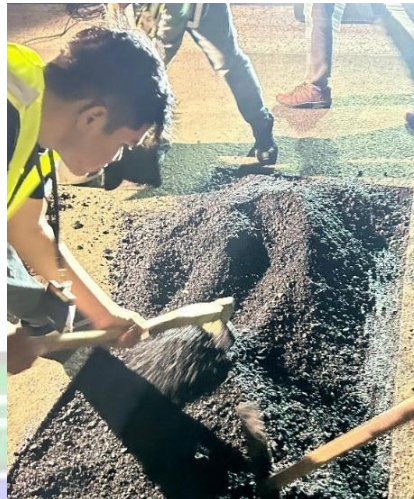
Gambar 4.28 Penuangan Asphalt Lapis Kedua (Sumber : Dokumentasi Penulis, 2024)
