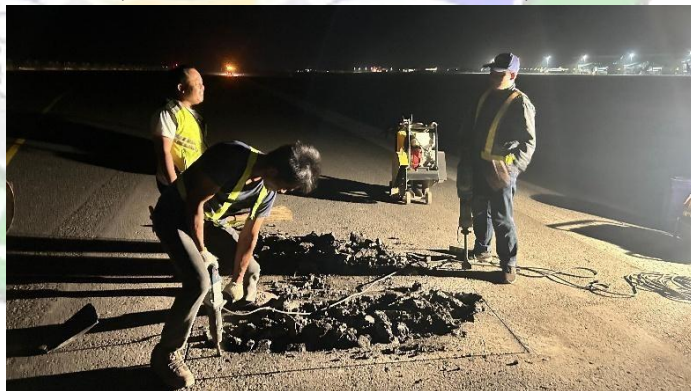
Gambar 4.20 Pembongkaran dengan Asphalt Cutter (Sumber : Dokumentasi Penulis, 2024)
