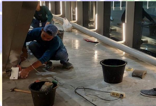
Gambar 4.39 Pembersihan Area Perbaikan (Sumber : Dokumentasi Penulis, 2024)
