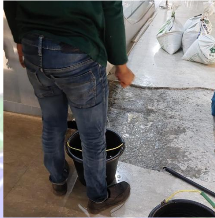
Gambar 4.34 Pemberian Air pada Lantai (Sumber : Dokumentasi Penulis, 2024)
