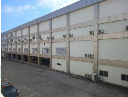
Gambar 4.12 Main Power House (MPH) (Sumber : Dokumentasi Penulis, 2025)
