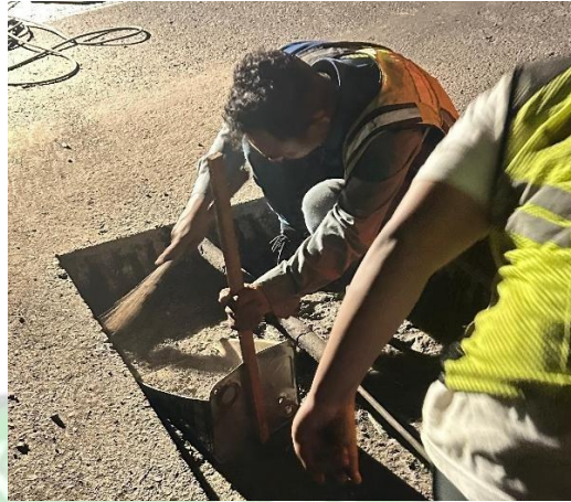
Gambar 4.22 Pembersihan Lokasi Penambalan (Sumber : Dokumentasi Penulis, 2024)
