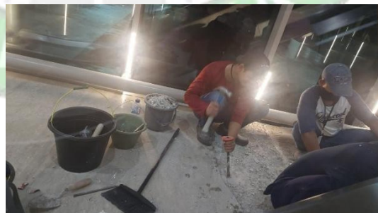
Gambar 4.33 Pembersihan Lokasi Perbaikan (Sumber : Dokumentasi Penulis, 2024)
