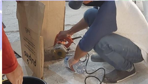
Gambar 4.32 Pemotongan Lantai Marmer (Sumber : Dokumentasi Penulis, 2024)
