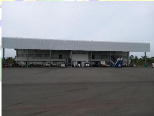
Gambar 4.17 Gedung Line Maintenance (Sumber : Dokumentasi Penulis, 2025)
