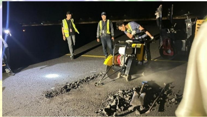
Gambar 4.20 Pembongkaran dengan Asphalt Cutter (Sumber : Dokumentasi Penulis, 2024)
