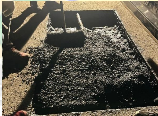
Gambar 4.25 Penghamparan Asphalt Lapis Pertama (Sumber : Dokumentasi Penulis, 2024)
