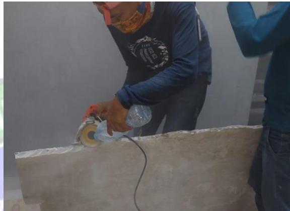
Gambar 4.36 Pemotongan Lantai Marmer (Sumber : Dokumentasi Penulis, 2024)
