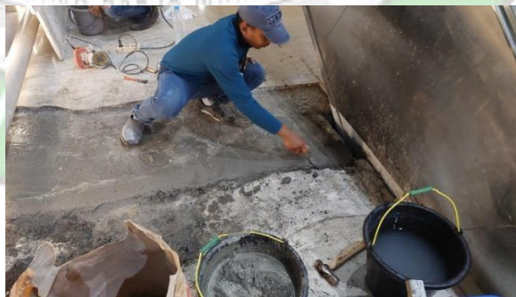
Gambar 4.37 Proses Penuangan Spesi (Sumber : Dokumentasi Penulis, 2024)
