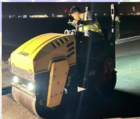
Gambar 4.29 Proses Pemadatan Kedua (Sumber : Dokumentasi Penulis, 2024)
