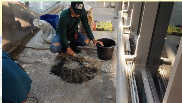
Gambar 4.35 Pembuatan Spesi (Sumber : Dokumentasi Pribadi, 2024)
