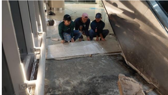
Gambar 4.38 Pemasangan Lantai Marmer (Sumber : Dokumentasi Penulis, 2024)
