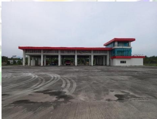
Gambar 4.15 Sub Fire Station (Sumber : Dokumentasi Penulis, 2025)
