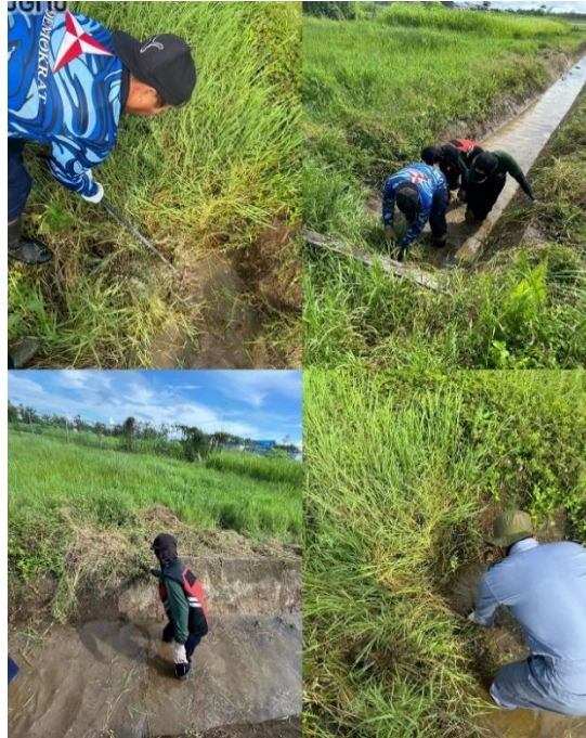
Gambar 4. 20 Pembersihan Endapan Rumput dan Endapan Tanah (Sumber : Dokumentasi Penulis, 2024)
