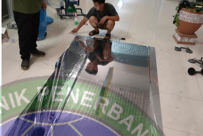
Gambar 4. 29 Pemasangan Kaca Film pada Solar Tuff (Sumber: Dokumentasi Penulis, tahun 2024)
