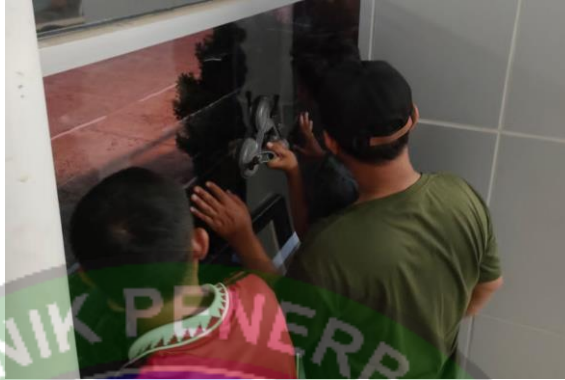
Gambar 4. 31 Pemasangan Kaca dibantu dengan Alat Kop Kaca (Sumber: Dokumentasi Penulis 2024)
