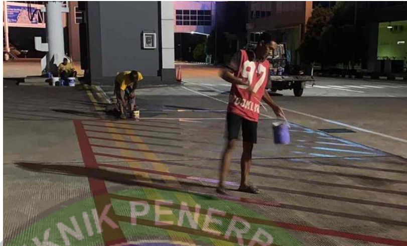
Gambar 4. 20 Proses Pencampuran Cat dengan Thinner dan Proses Pengecatan (Sumber: Dokumen Penulis)
