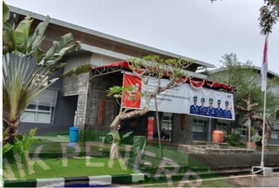
Gambar 4. 10 Gedung Administrasi (Sumber: Dokumentasi Penulis 2024)
