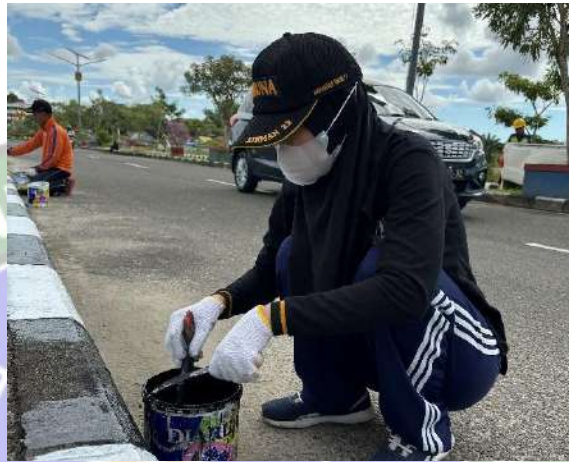
Gambar 4. 14 Pengecatan kanstin
