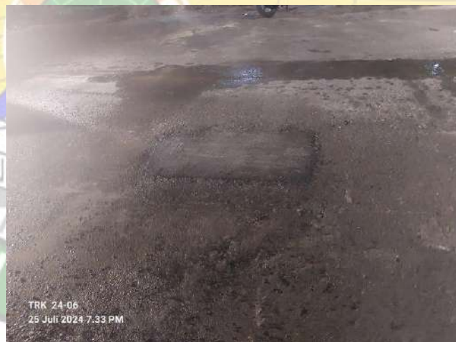
Gambar 4. 11 Hasil setelah patching
