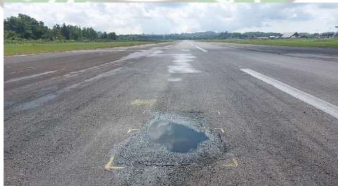
Gambar 4. 2 Kerusakan Depression di Runway STA 1+350
