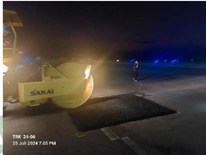
Gambar 4. 10 Pemadatan Menggunakan Tandem Roller
