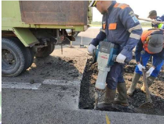
Gambar 4. 5 Pembongkaran Lapisan Aspal
