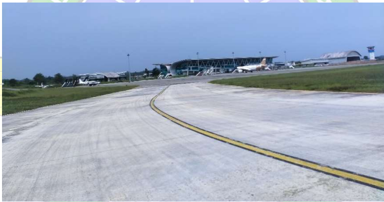
Gambar 4. 2 Landasan Hubung (Taxiway) (Sumber : Dokumentasi Penulis, 2024)
