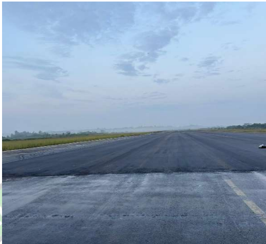
Gambar 4. 45 Kondisi Runway Setelah Pekerjaan Overlay
