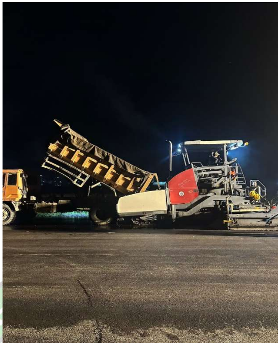
Gambar 4. 42 Pekerjaan Penghamparan Aspal (Sumber : Dokumen Penulis, 2024)
