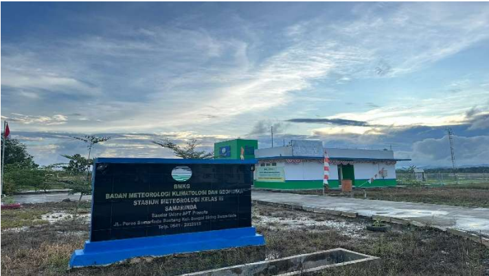
Gambar 4. 9 Bangunan Meteorologi (BMKG,
