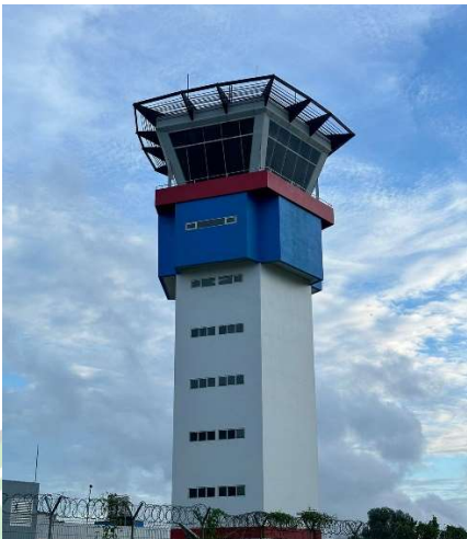
Gambar 4. 7 Bangunan Pengatur Lalu Lintas (ATC Tower)
