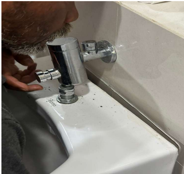
Gambar 4. 47 Proses Pembongkaran Urinoir (Sumber : Dokumen penulis, 2024)
