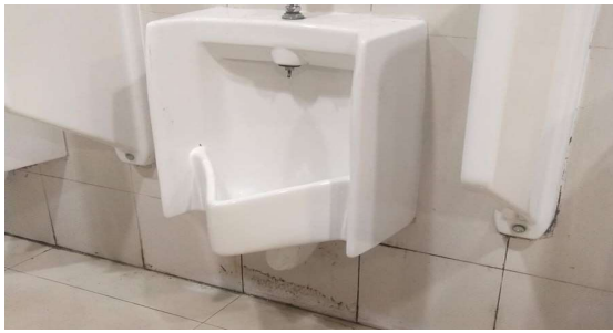
Gambar 4. 50 Kondisi Urinoir Setelah Melaksanakan Pekerjaan
