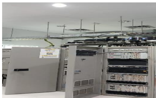
Gambar 3.20 Pengelola Data Radar PSR di Kantor Pusat Sumber: Hasil Dokumentasi Penulis 2024
