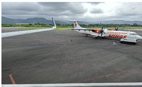
Gambar 4. 1 Belum Ada Marka EPA di Apron
