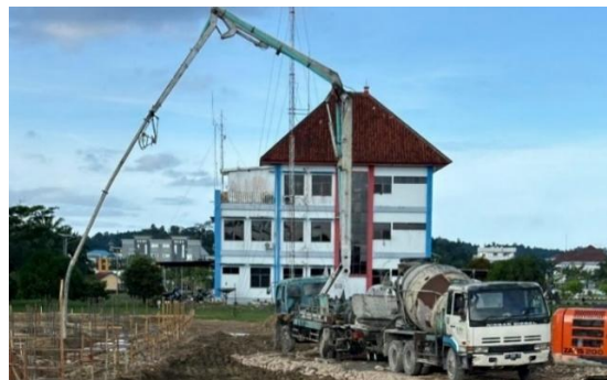
Gambar 4. 28 Bekisting dan pengecoran pile cap (Sumber : Dokumentasi Penulis)
