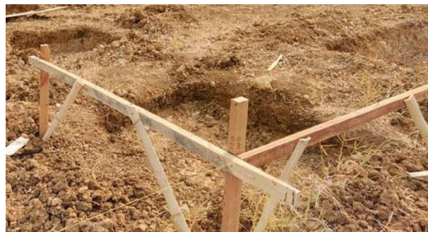
Gambar 4. 23 Pekerjaan bouwplank gudang kargo (Sumber : Drafter proyek gudang kargo)
