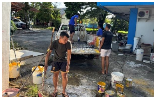
Gambar 4. 22 Finishing dan pembersihan (Sumber : Dokumentasi Penulis)
