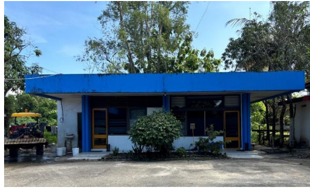
Gambar 4. 6 Gedung Landasan (Sumber : Dokumentasi Penulis)
