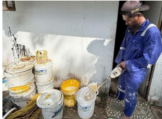
Gambar 4. 19 Pencampuran cat (Sumber : Dokumentasi Penulis)
