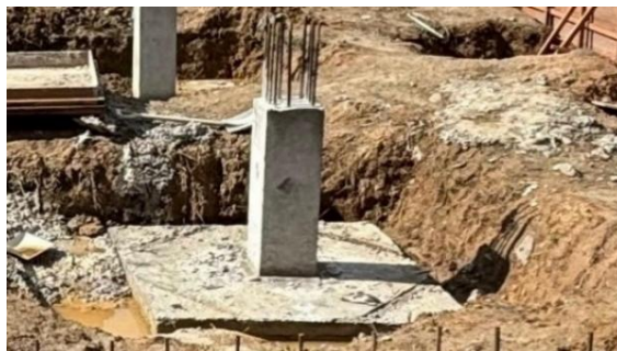
Gambar 4. 29 Hasil pengecoran pile cap dan pedestal (Sumber : Dokumentasi Penulis)
