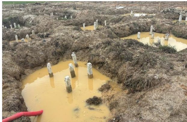
Gambar 4. 25 Pemasangan mini pile (Sumber : Dokumentasi Penulis)
