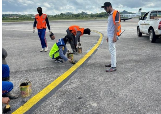
Gambar 4. 21 Pelaksanaan pengecatan (Sumber : Dokumentasi Penulis)
