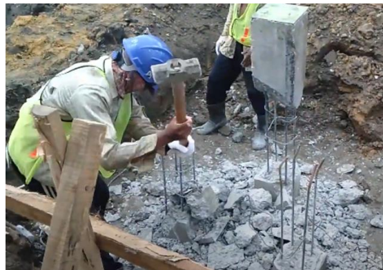
Gambar 4. 26 Pekerjaan pemecahan kepala tiang mini pile (Sumber : Dokumentasi Penulis)
