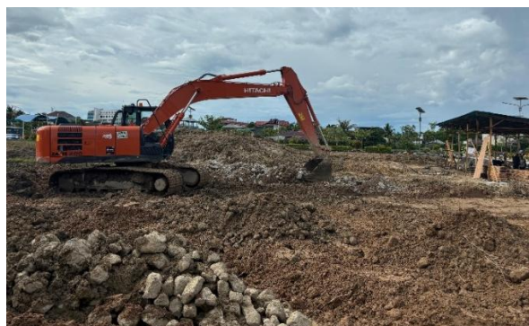
Gambar 4. 24 Penggalian titik pile cap (Sumber : Dokumentasi Penulis)
