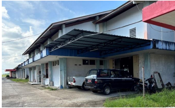
Gambar 4. 8 Gedung Power House (Sumber : Dokumentasi Penulis)
