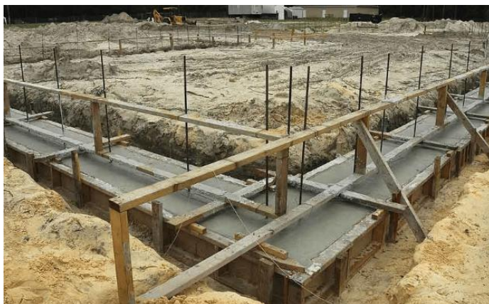
Gambar 3. 15 Pondasi Plat Beton Lajur (Sumber: grahamedia.id)
