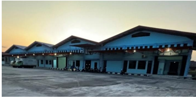
Gambar 4. 4 Gedung Kargo (Sumber : Dokumentasi Penulis)
