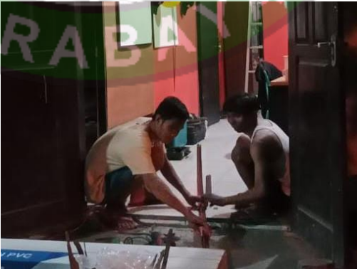
Gambar 4. 36 Pemotongan Bingkai Plafon
