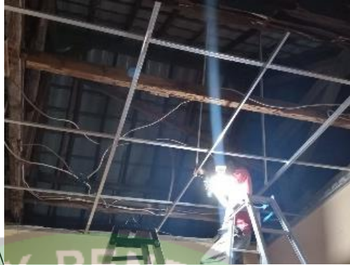
Gambar 4. 34 Pemasangan Rangka besi hollow
