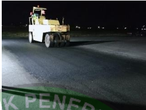
Gambar 4. 23 Pemadatan dengan TR Roller
