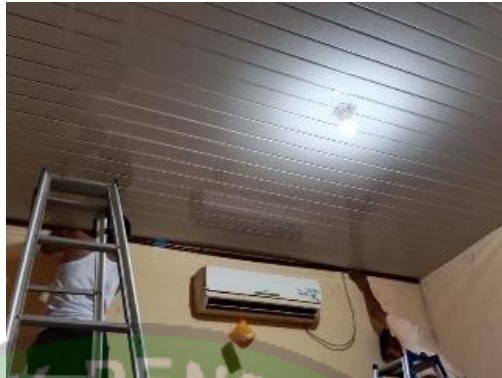
Gambar 4. 37 Pemasangan Bingkai Plafon
