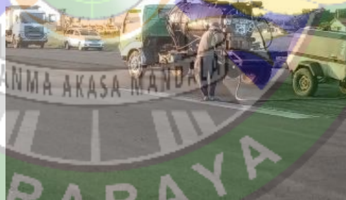
Gambar 4. 18 Pembersihan sisa material area pemotongan Alligator Cracks
