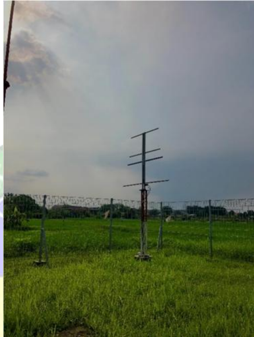
Gambar 3. 14 Middle Marker di Bandar Udara Internasional Juanda Surabaya Sumber : Dokumentasi Penulis 2024
