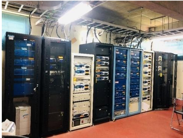
Gambar 3. 6 Radio Transmitter VHF A/G Sumber : Dokumentasi Penulis 2024
