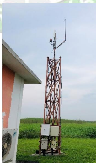
Gambar 3. 19 Antenna Peralatan RU (Remote Unit) MLAT Sumber : Dokumentasi Penulis 2024
