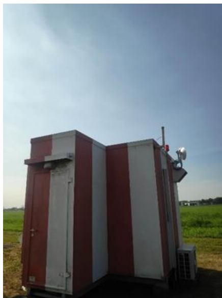
Gambar 3. 13 Shelter Glide Path merk Normac Sumber : Dokumentasi Penulis 2024
