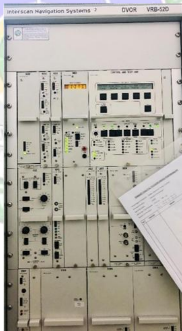
Gambar 3. 8 Transmitter DVOR Merk InterScan Sumber : Dokumentasi Penulis 2024
