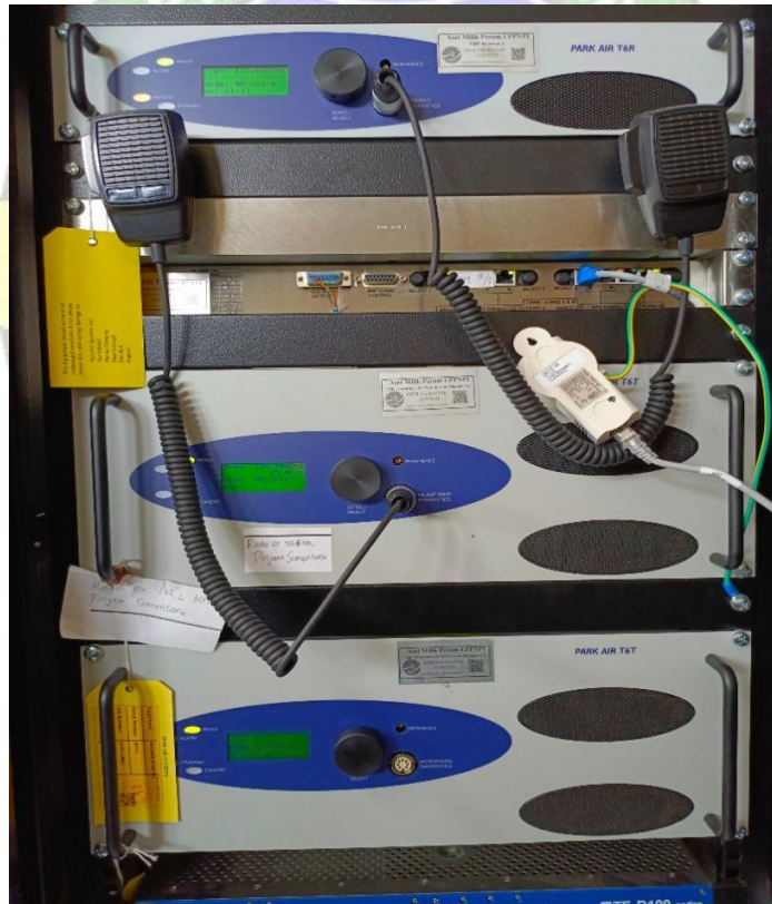
Gambar 3. 32 Visual Radio VHF-ER Merk PAE Sumber : Dokumentasi penulis 2024
