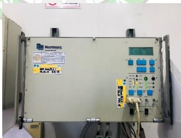
Gambar 3. 15 Front Pannel Middle Marker di Bandara Juanda Surabaya Merek Normarc Sumber : Dokumentasi Penulis 2024
