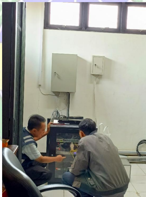
Gambar 3. 34 Pengecekan Jalur VSAT Sumber : Dokumentasi Penulis 2024
