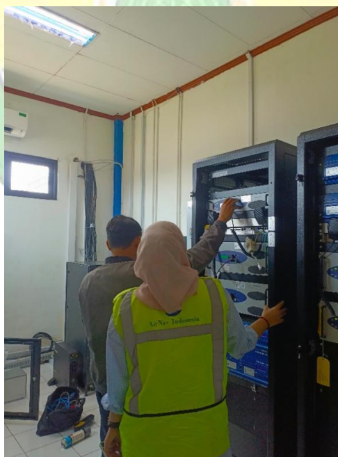
Gambar 3. 38 Teknisi meng uji coba Radio VHF-ER Sumber : Dokumentasi Penulis 2024
