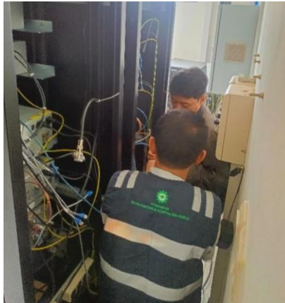
Gambar 3. 35 Pengecekan Jalur dari Radio VHF-ER ke VSAT Sumber : Dokumentasi Penulis 2024
