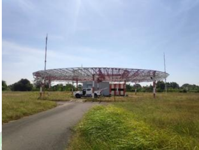
Gambar 3. 7 Antenna Peralatan DVOR Merk Intrerscam Sumber : Dokumentasi Penulis 2024
