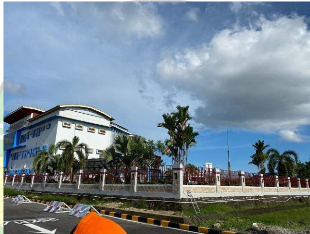
Gambar 4. 12 Pagar Yang Belum Sesuai Pada Perbatasan Kantor
