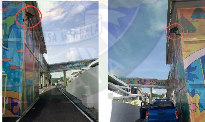
Gambar 4. 15 Contoh penempatan CCTV di area service road (Sumber: Dokumentasi penulis)
