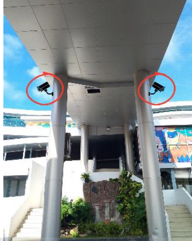
Gambar 4. 16 Contoh penempatan CCTV di area access road (Sumber: Dokumentasi penulis)
