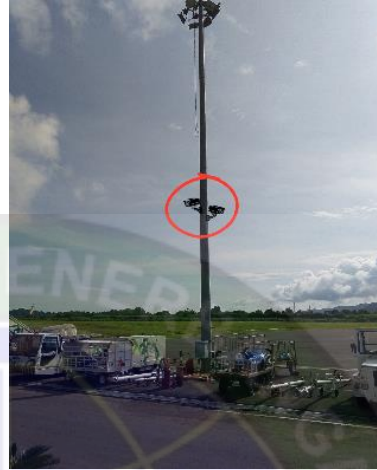
Gambar 4. 14 Contoh penempatan CCTV di area parking stand 1 (Sumber: Dokumentasi penulis)
