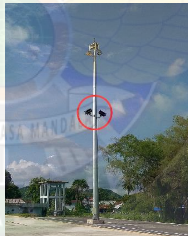
Gambar 4. 17 Contoh penempatan CCTV di parking stand 8 (Sumber: Dokumentasi penulis)
