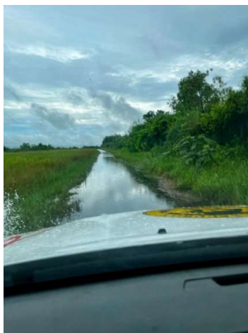
Gambar 4.18 Air tergenang karena rerumputan menutupi saluran air
