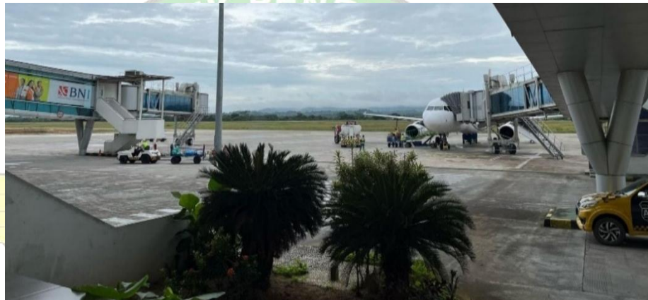
Gambar 4. 4 Wilayah Kerja Airside Apron Movement Control (Sumber : Bandar Udara A.P.T. Pranoto Samarinda)
