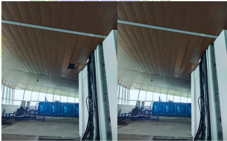
Gambar 4. 31 Perbaikan Celah Pada Atap (Sumber : Dokumentasi Penulis)
