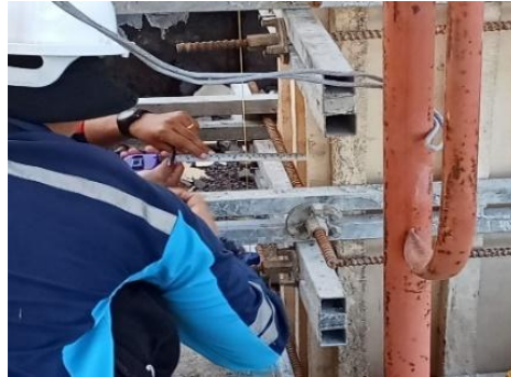
Gambar 4. 53 Pengukuran verticality (Sumber : Dokumentasi penulis 2024)
