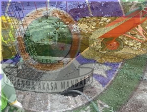
Gambar 4. 50 Pengecoran Pondasi (Sumber : Dokumentasi penulis 2024)
