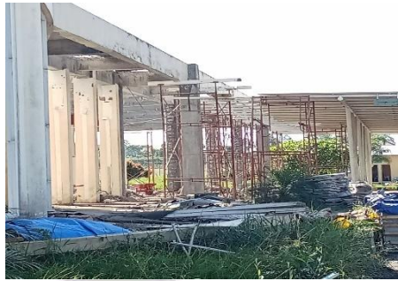
Gambar 4. 55 kolom bantu (Sumber : Dokumentasi penulis 2024)
