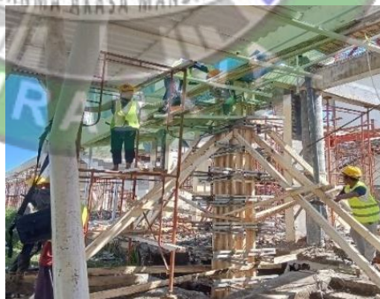
Gambar 4. 54 pengecoran kolom (Sumber : Dokumentasi penulis 2024)
