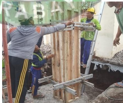
Gambar 4. 52 pemasangan bekisting (Sumber : Dokumentasi penulis 2024)
