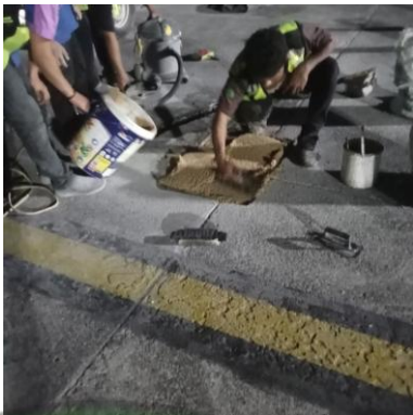
Gambar 4. 17 Pekerjaan Pelapisan (Sumber : Dokumentasi Penulis 2024)
