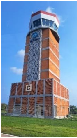
Gambar 4. 9 Menara ATC (Sumber: Dokumentasi Penulis 2024)
