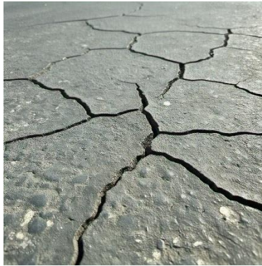
Gambar 3. 4 Retak Susut (Sumber : www.googlemaps.com 2024)
