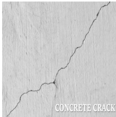
Gambar 3. 2 Retak Diagonal (Sumber : www.googlemaps.com 2024)
