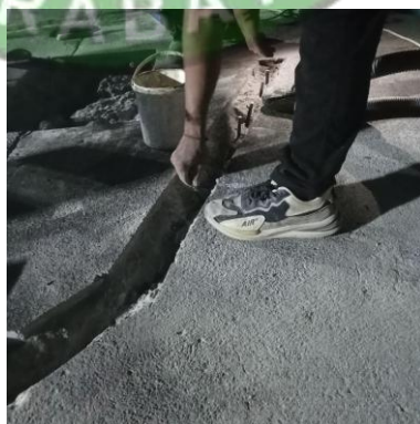
Gambar 4. 14 Pemasangan Tulangan (Sumber : Dokumentasi Penulis 2024)
