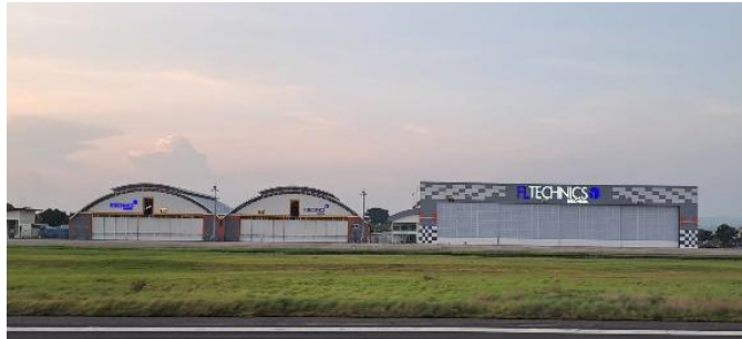
Gambar 4. 11 Hanggar Bandara I Gusti Ngurah Rai (Sumber: Dokumentasi Penulis 2024)
