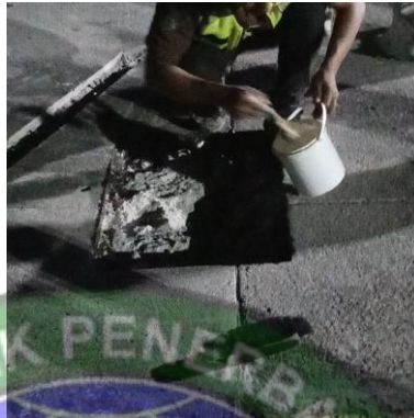
Gambar 4. 15 Pelapisan Stronggrout (Sumber : Dokumentasi Penulis 2024)
