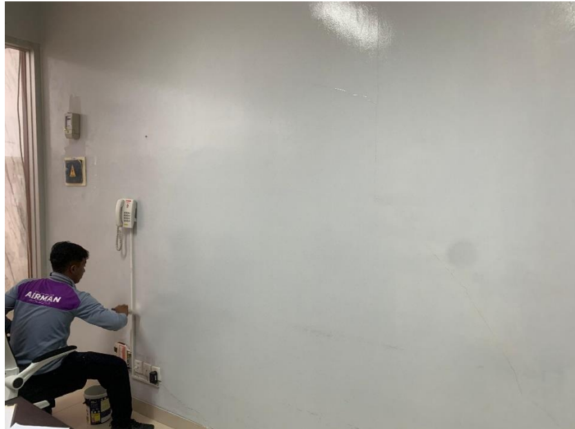
Gambar 4. 11 pengecatan dinding tembok menggunakan kuas Sumber : Dokumentasi pribadi, 2025
