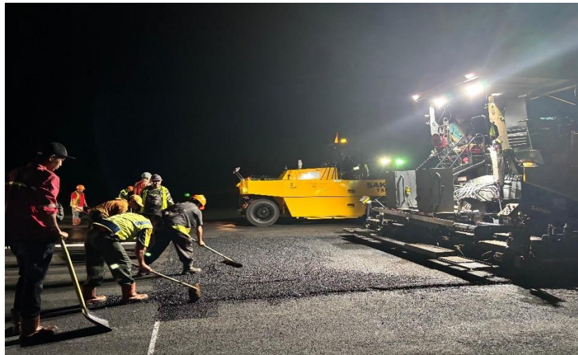
Gambar 4. 7 Penghamparan campuran aspal AC-WC
