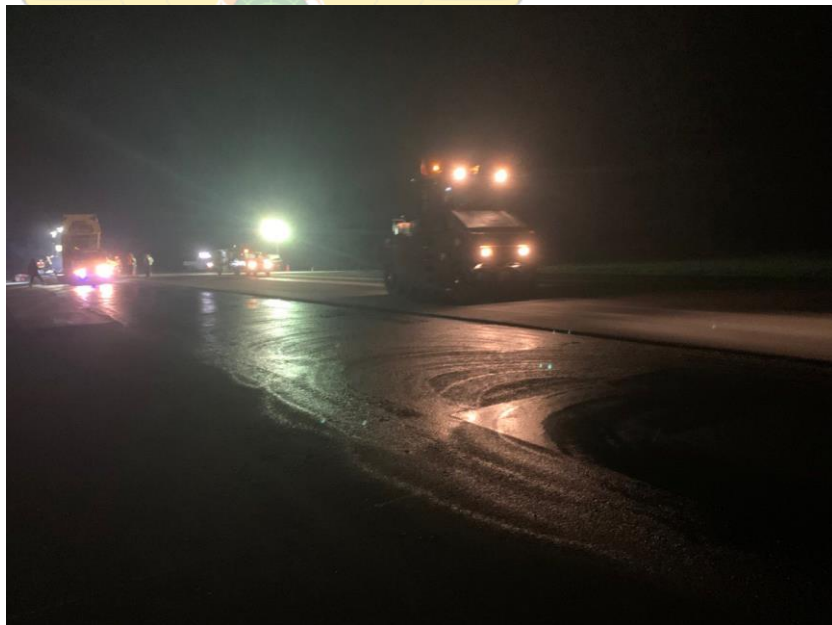
Gambar 4. 6 Penyemprotan tack coat
