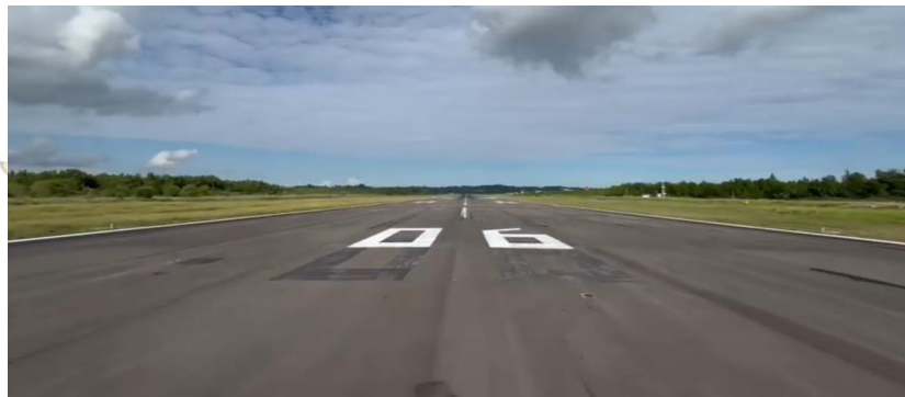
Gambar 4. 9 Kondisi Runway Setelah Dilakukan Pengecatan Marka Sumber : Dokumentasi pribadi, 2025
