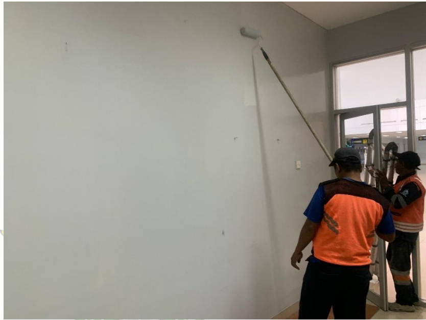
Gambar 4. 10 Pengecatan dinding tembok menggunakan kuas roll
