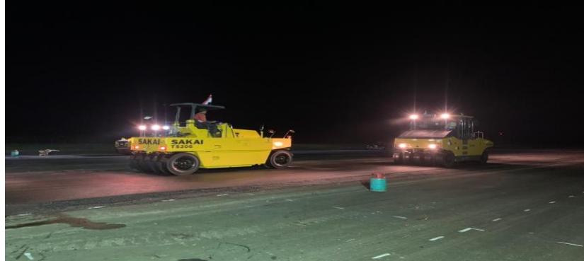
Gambar 4. 8 Perataan dan pemadatan Sumber : Dokumentasi pribadi, 2025
