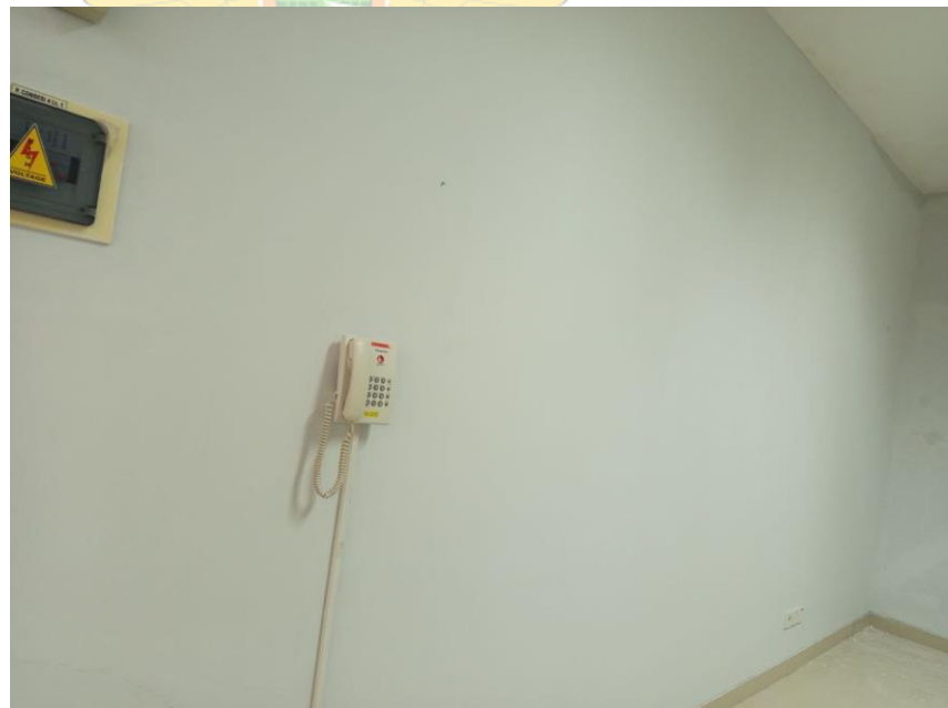
Gambar 4. 12 Hasil pekerjaan pengecatan Sumber : Dokumentasi pribadi, 2025
