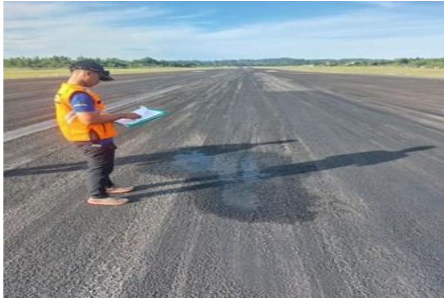
Gambar 4. 1 Kondisi runway sebelum overlay Sumber : Dokumentasi pribadi, 2025
