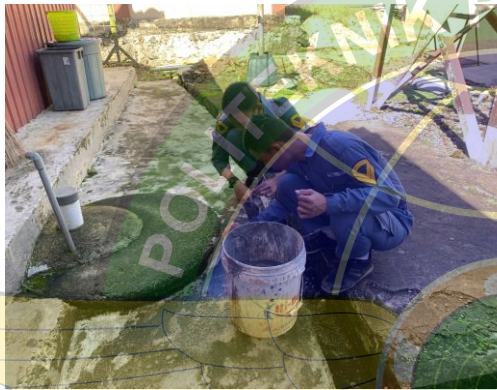
Pengecoran tutup septic tank
