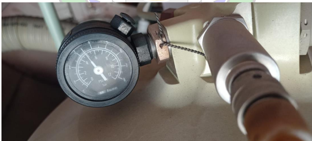
Gambar 4.36 pengecekan tekanan reservoir pada pressure gauge
