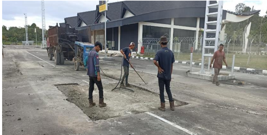
Gambar 4.12 Pembersihan area yang akan di patching (sumber : olahan penulis, 2023)
