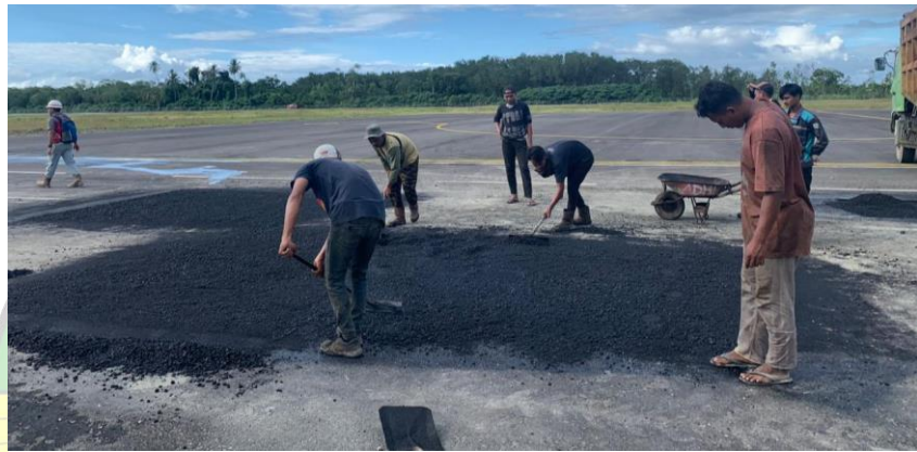
Gambar 4.14 Penghamparan asphalt (sumber : olahan penulis, 2023)
