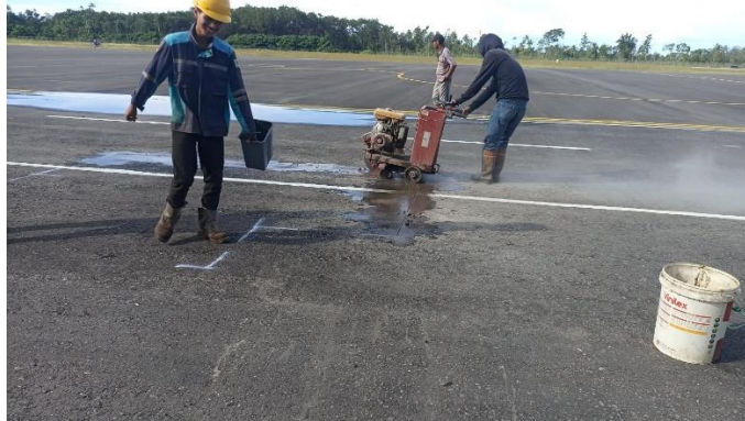
Gambar 4. 10 Proses pemotongan (sumber : olahan penulis, 2023)
