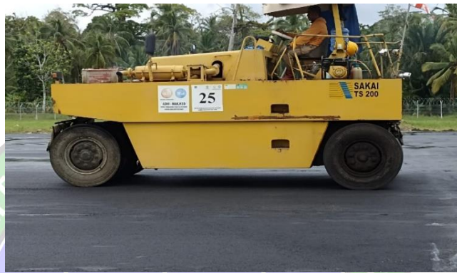
Gambar 4.17 Proses pemadatan dengan pneumatic tire roller (sumber : olahan penulis, 2023)
