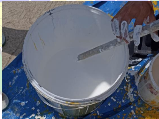
Gambar 4.22 Pekerjaan pencampuran cat dengan air (sumber : olahan penulis, 2023)
