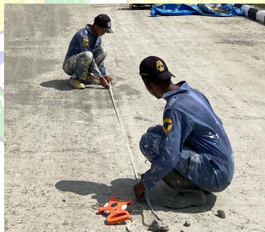
Gambar 4.20 Proses pengukuran marka (sumber : olahan penulis, 2023)
