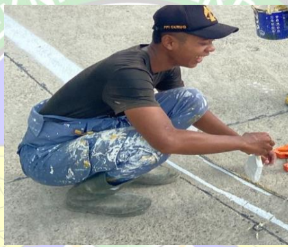
Gambar 4.24 Pekerjaan pengecatan dengan kuas (sumber : olahan penulis, 2023)
