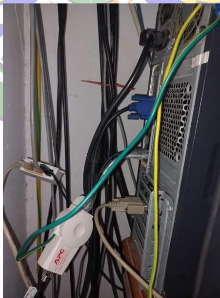
Gambar 3.38 Pemasangan Surge Protector
