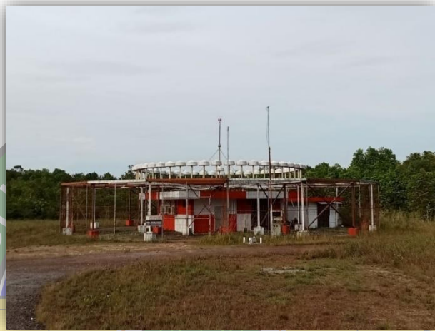
Gambar 3.11 Antena DVOR
