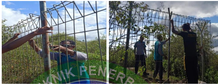
Gambar 4.12 Perbaikan Pagar Perimeter
