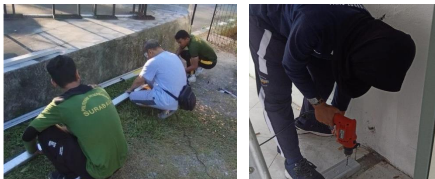
Gambar 4.15 Pembuatan Sekat Locker Room
