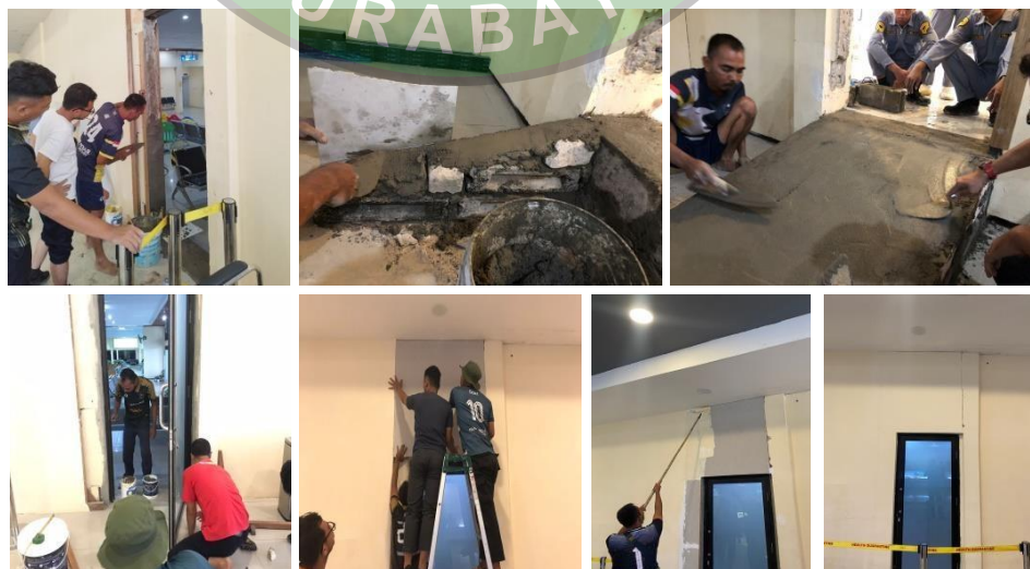
Gambar 4. 12 Proses Pembuatan Pintu Keluar Darurat
