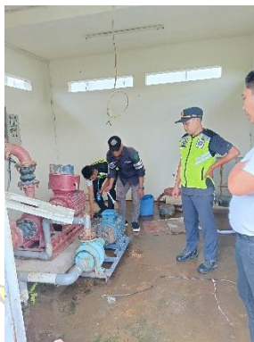
11. Perbaikan motor pompa 3 phase
