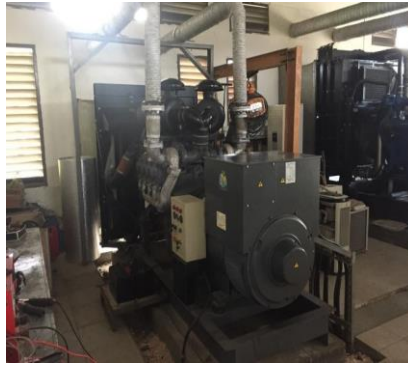
Gambar 4. 1 Genset 500 KVA PH Bandara Halu Oleo Kendari Sumber : Dokumentasi Pribadi
