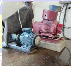
Gambar 4. 21 Pemasangan Terpal Penutup antara Motor dan Pompa Sumber : Dokumentasi Pribadi
