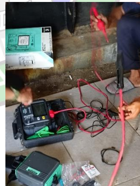
17. Perbaikan kabel primer taxiway
