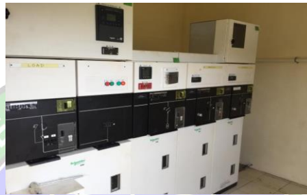
Gambar 4. 8 Fisik Cubicle MV MBD
