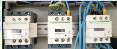
Gambar 3. 2 Kontaktor Sumber : Dokumentasi Pribadi
