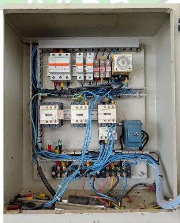
Gambar 4. 22 Panel Pompa Mootor 3 Phasa Sumber : Dokumentasi Pribadi
