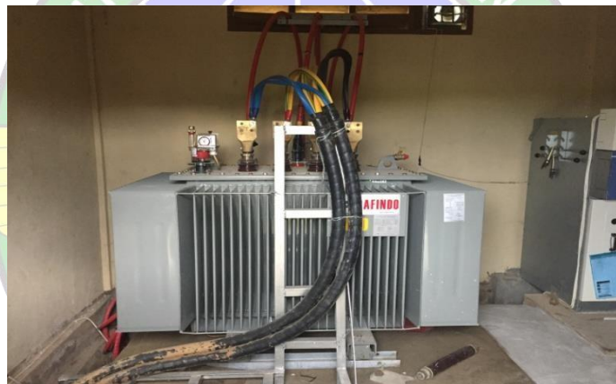
Gambar 4. 5 Transformator Step-Up PH Sumber : Dokumentasi Pribadi
