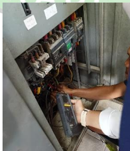
Gambar 4. 17 Pengetesan Dengan Suplai 3 Phase Sumber : Dokumentasi Pribadi
