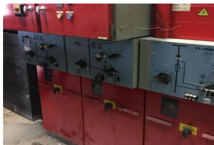
Gambar 4. 9 Fisik Cubicle LVMDP
