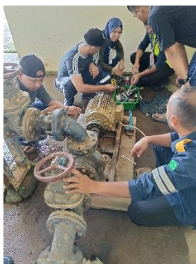
12. Pergantian impeller motor pompa
