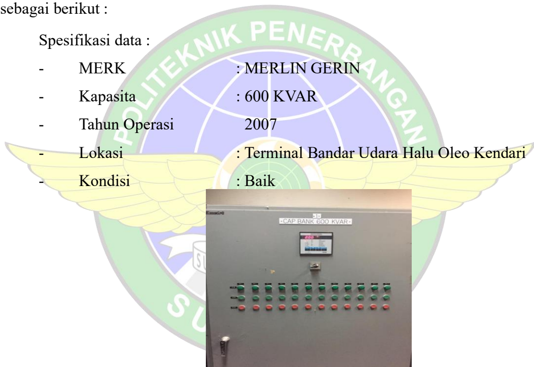
Gambar 4. 10 Capasitor Bank Sumber : Dokumentasi Pribadi
