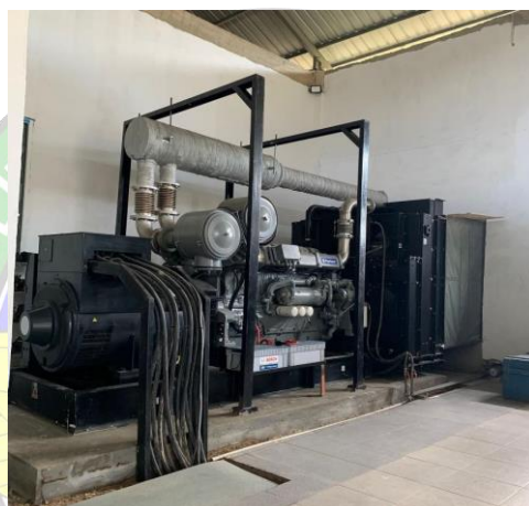
Gambar 4. 3 Genset 1000 KVA 2 PH Bandara Halu Oleo Kendari
