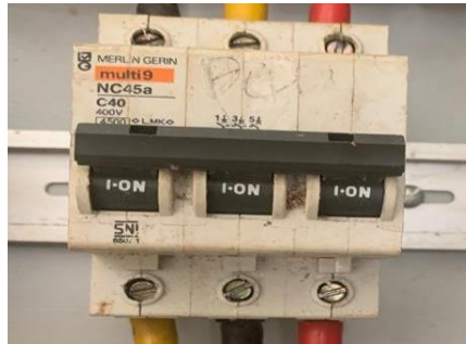
Gambar 3. 8 Main Circuit Breaker Sumber : Dokumentasi Pribadi
