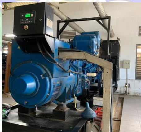
Gambar 4. 2 Gambar Fisik Genset 1000 KVA 1 Sumber : Dokumentasi Pribadi
