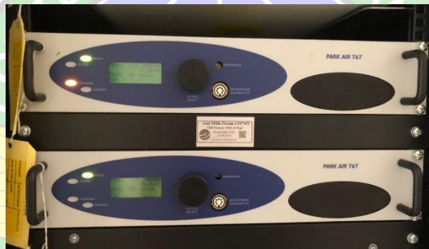
Gambar 3. 1 VHF transmitter A/G Primary TWR Sumber: Dokumentasi Penulis, 21 November 2023
