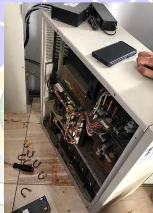
Gambar 3. 26 Pelepasan Battery UPS
