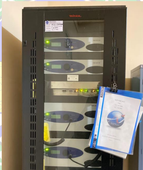
Gambar 3. 8 VHF Transceiver ER A/G ACC Sumber: Dokumentasi Penulis, 21 November 2023
