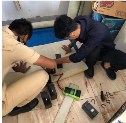
Gambar 3. 27 Pengecekan Battery UPS Sumber: Dokumentasi Penulis, 22 November 2023
