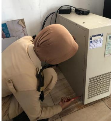
Gambar 3. 25 Pelepasan UPS
