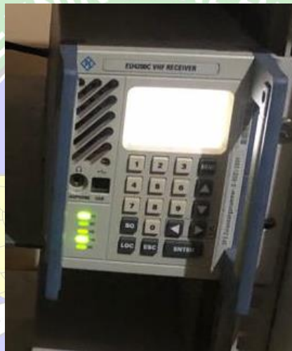
Gambar 3. 4 VHF receiver ER A/G TWR
