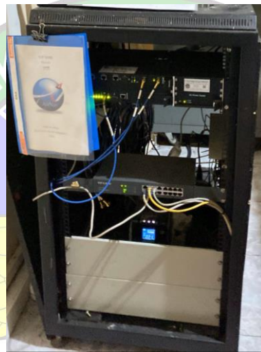
Gambar 3. 19 Rak ADS-B Sumber: Dokumentasi Penulis, 5 Oktober 2023
