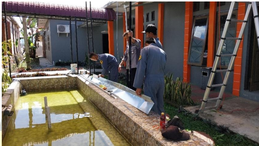
Gambar 4.17 Proses pembentukan seng polos (Sumber: Dokumentasi Penulis, 2023)
