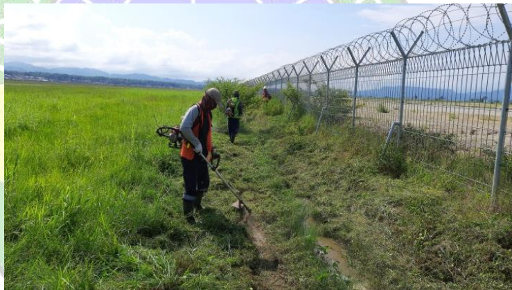
Gambar 4.24 Pembersihan saluran dari rumput liar (Sumber: Dokumentasi Penulis, 2023)
