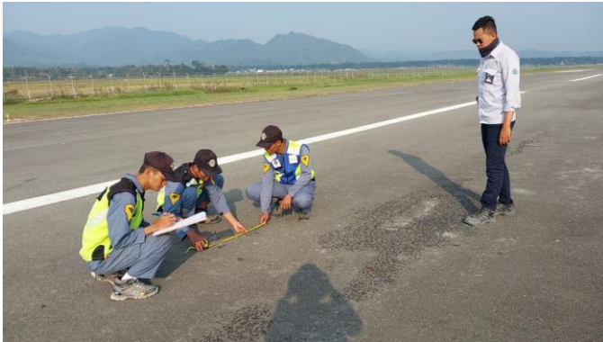
Melakukan survei kerusakan lapisan permukaan landasan
