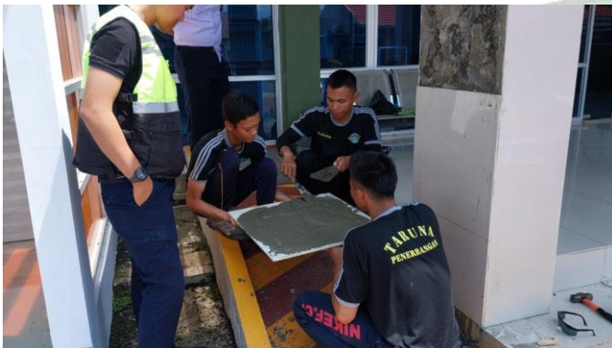
Melakukan perbaikan keramik di terminal
