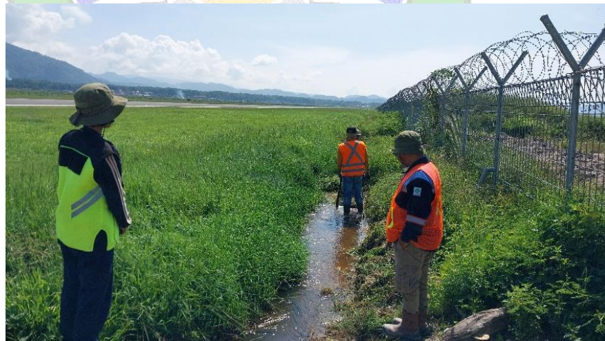
Gambar 4.22 Pemeriksaan saluran yang tersumbat (Sumber: Dokumentasi Penulis, 2023)
