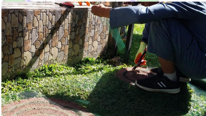
Gambar 4.18 Proses pemotongan ram jaring (Sumber: Dokumentasi Penulis, 2023)
