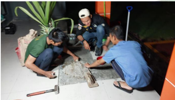
Melakukan perbaikan lantai keramik gedung kantor administrasi
