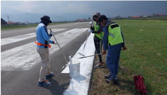
Melakukan pengecatan side stripe marking di landasan
