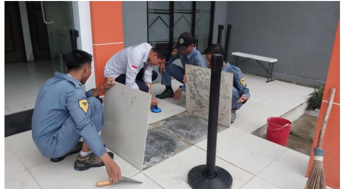
Melakukan perbaikan keramik di gedung kantor administrasi
