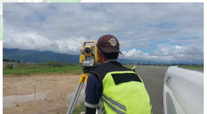
Pengukuran di landasan dengan alat Total Station
