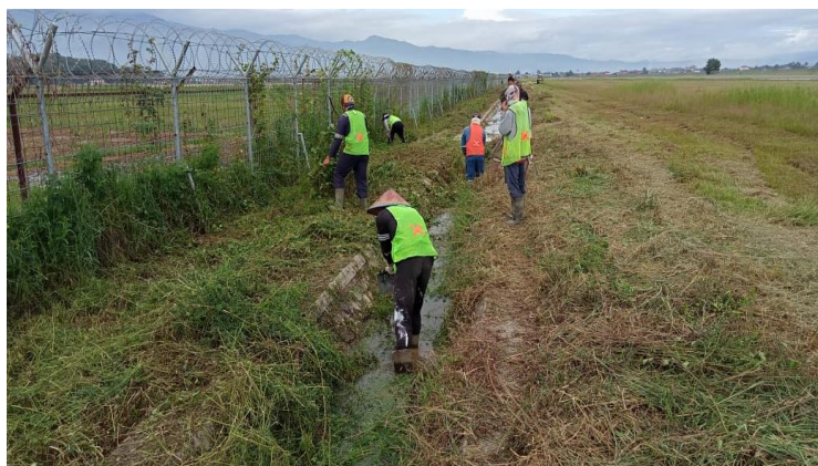
Gambar 4.25 Pembersihan saluran air (Sumber: Dokumentasi Penulis, 2023)
