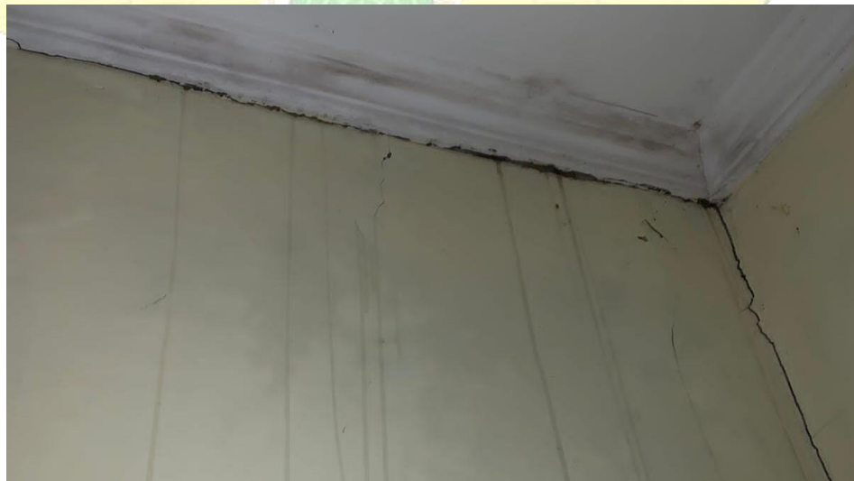
Gambar 4.11 Kondisi Kebocoran Atap Gedung Kantor Administrasi (Sumber: Dokumentasi Penulis, 2024)
