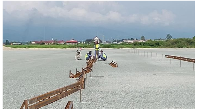
Pengukuran di apron dengan alat Total Station
