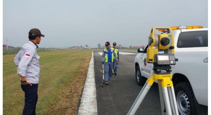
Melakukan pengukuran side stripe marking di landasan
