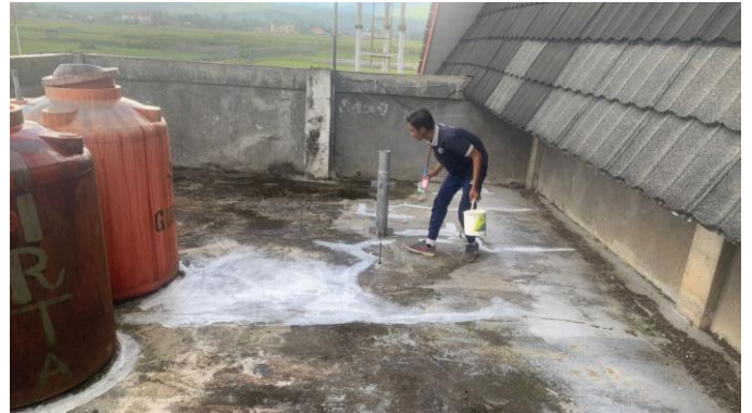
Melakukan pelapisan cat pada kebocoran atap terminal
