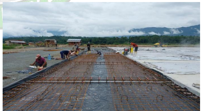
Peletakan besi tulangan di apron
