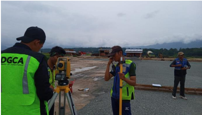
Pengukuran di apron dengan alat Total Station
