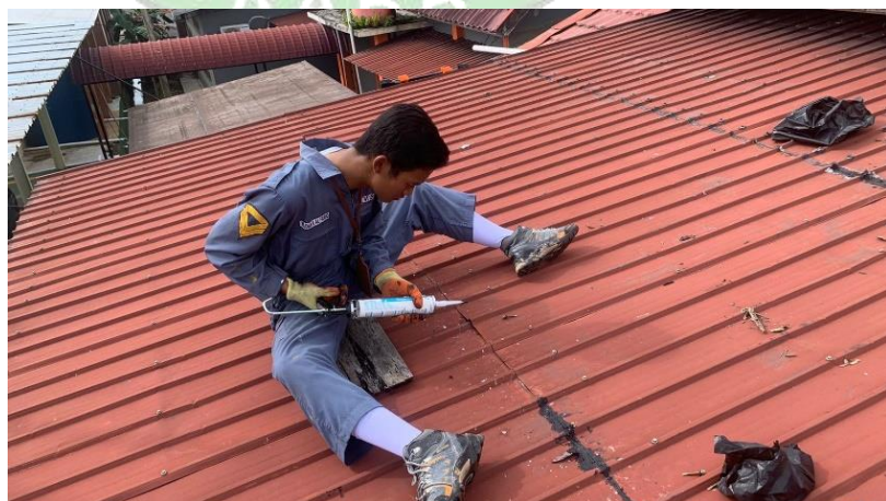
Gambar 4.20 Pelapisan celah atap (Sumber: Dokumentasi Penulis, 2023)
