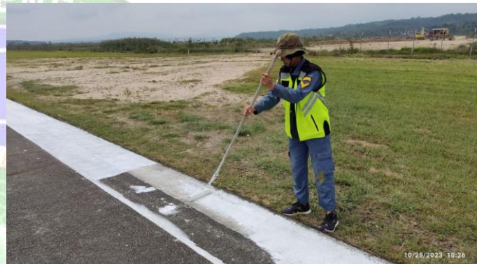
Melakukan pengecatan marka landasan
