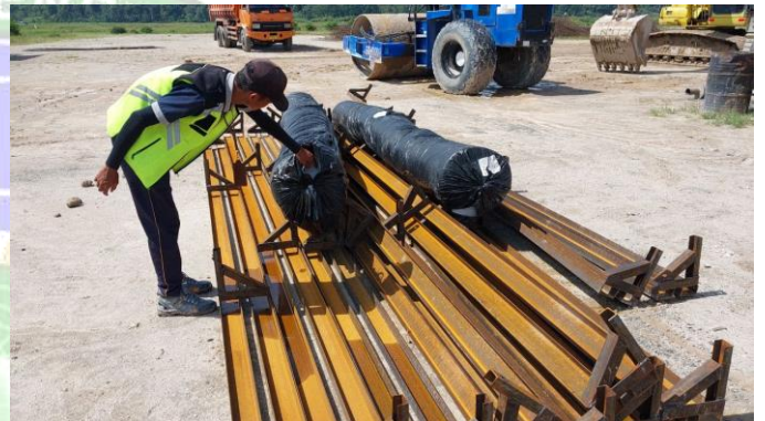
Melakukan pemeriksaan pada bekisting
