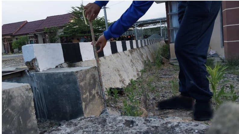
Gambar 4.9 Pengukuran Perbedaan Tinggi Tanah
