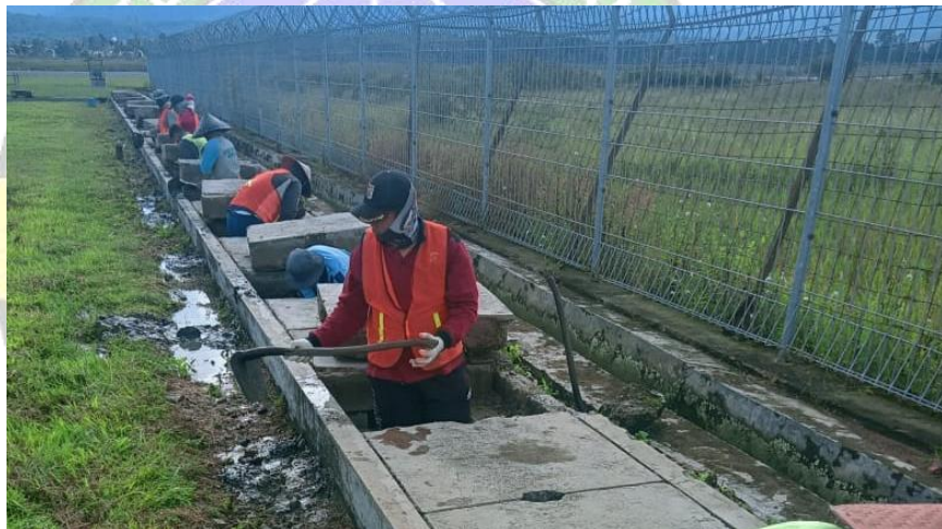
Gambar 4.13 Proses Pembersihan Saluran
