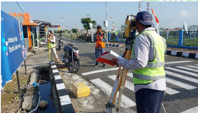
Mengukur ketinggian tanah sisi darat dengan Total Station
