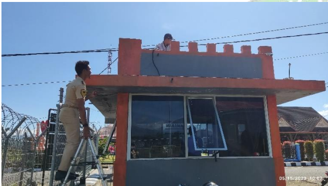
Waterproofing pada dak atap pos 1
