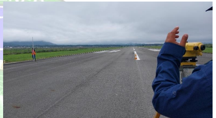
Mengukur ketinggian tanah sisi udara dengan Waterpass
