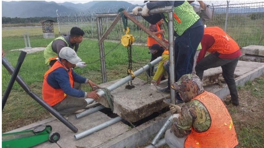
Gambar 4.12 Proses Pembukaan Tutup Saluran
