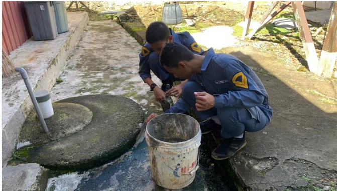
Melakukan pengecoran pada septic tank yang bocor
