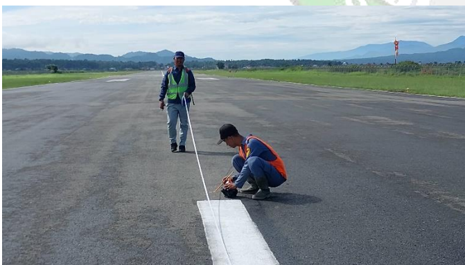
Mengukur dan membuat tanda di runway tiap 5 m
