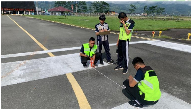
Mengukur marka di Landasan
