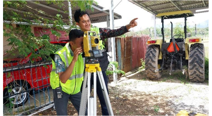
Mengukur obstacle menggunakan Total Station
