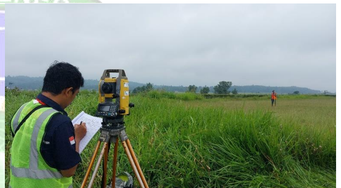
Mengukur RESA 12 dengan Total Station
