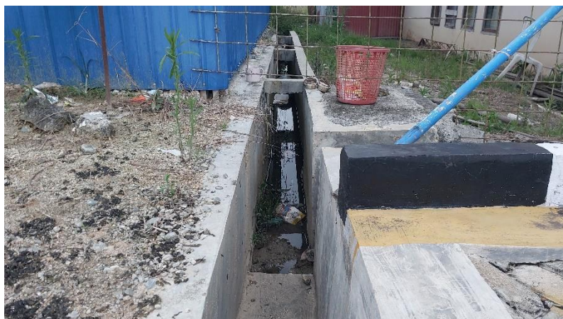
Gambar 4.11 Endapan Lumpur dan Sampah pada Drainase Eksisting
