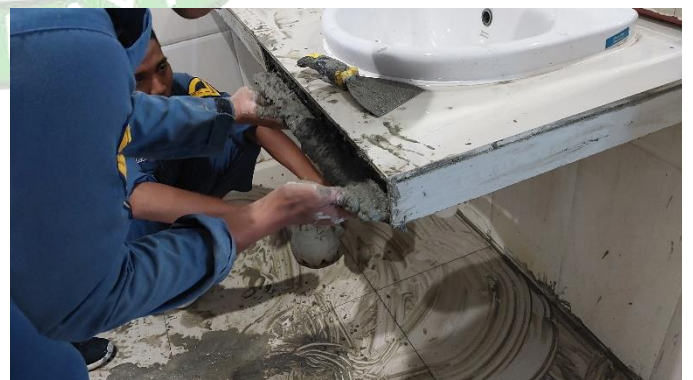
Memasang keramik untuk wastafel toilet terminal
