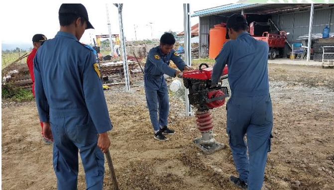
Meratakan tanah menggunakan stamper
