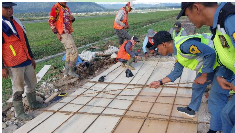
Gambar 4.17 Pemasangan Triplek dan Tulangan Beton
