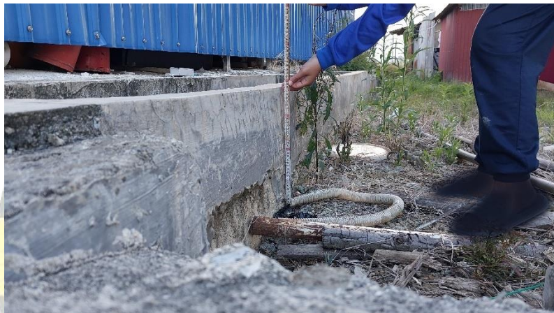
Gambar 4.10 Pengukuran Perbedaan Tinggi Tanah
