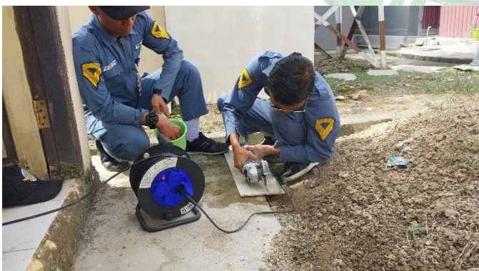
Memotong keramik untuk wastafel toilet terminal
