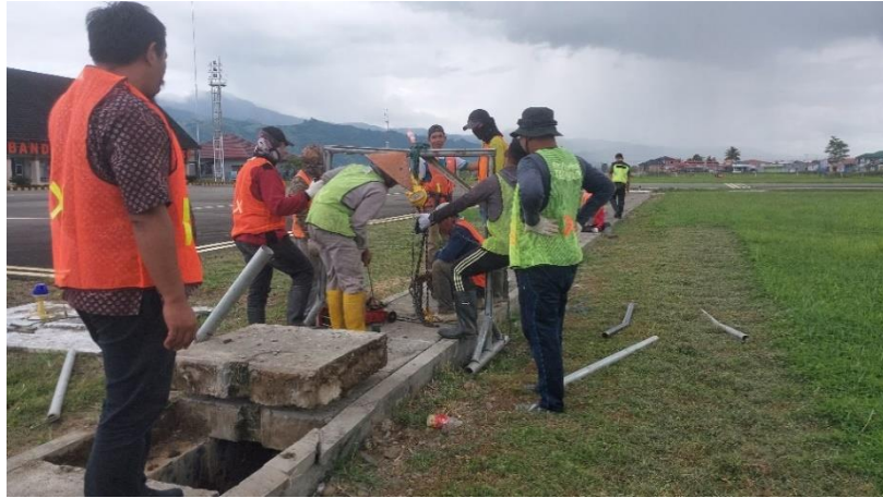
Gambar 4.15 Proses Penutupan Kembali Saluran
