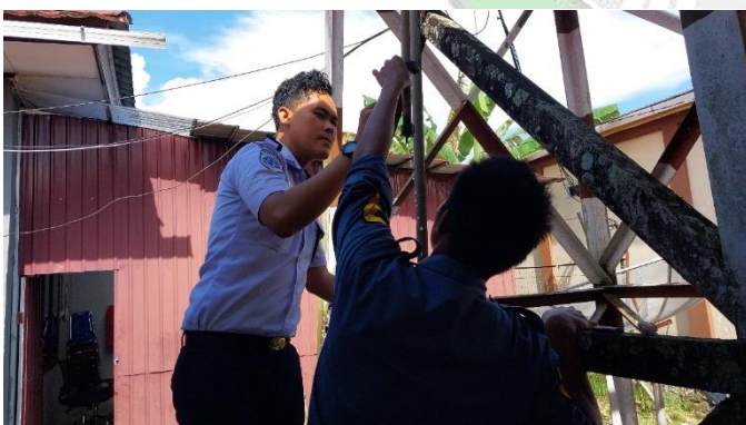
Memasang sambungan pipa air
