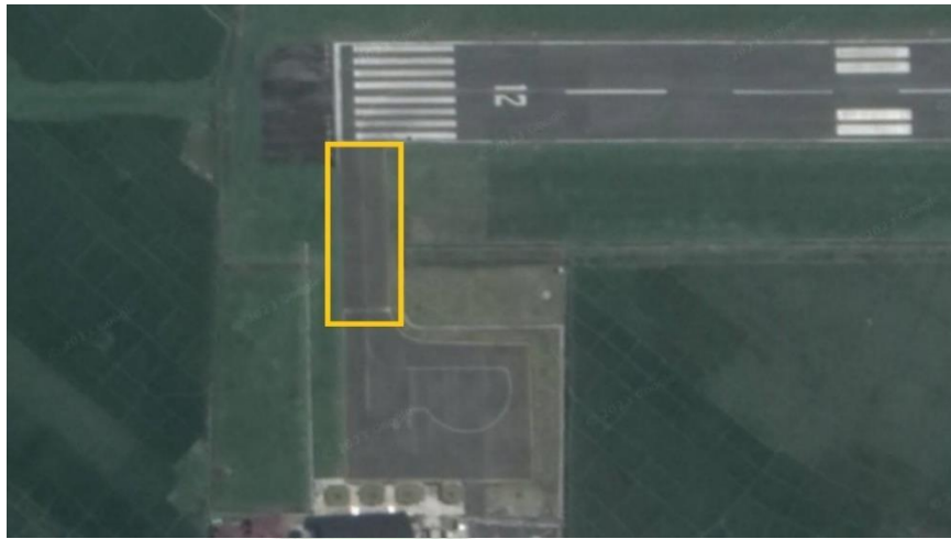
Gambar 4.2 Tampak Satelit Taxiway Bandara Depati Parbo Kerinci (Sumber: Google Earth diakses pada tanggal 11 Juli 2023)
