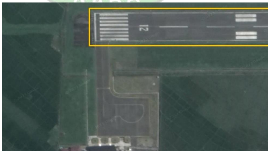
Gambar 4.3 Tampak Satelit Runway Bandara Depati Parbo Kerinci (Sumber: Google Earth diakses pada tanggal 11 Juli 2023)
