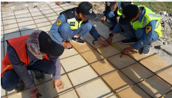
Menata besi untuk tulangan tutup drainase sisi udara
