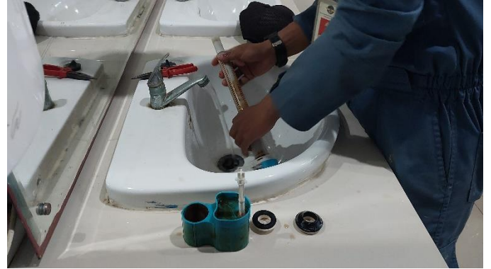
Membersihkan pipa pada flush toilet terminal
