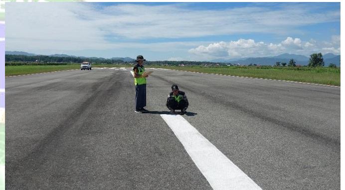
Mengukur seluruh marka runway
