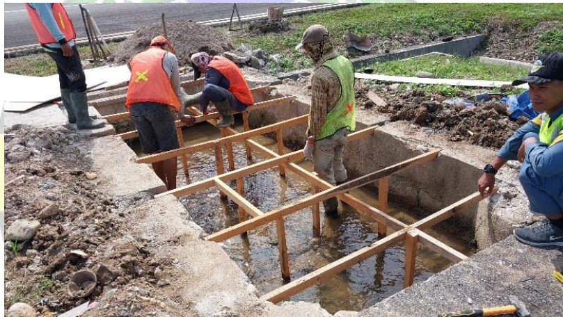
Gambar 4.16 Pembuatan Rangka Kayu
