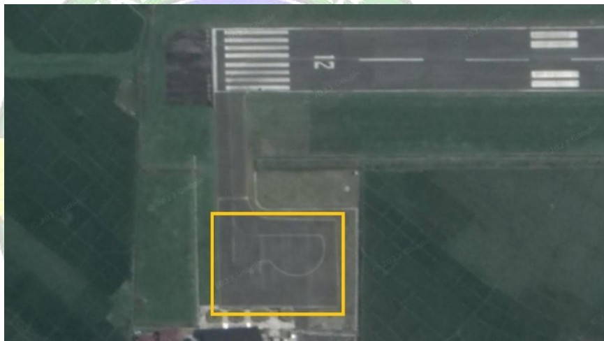
Gambar 4.1 Tampak Satelit Apron Bandara Depati Parbo Kerinci (Sumber: Google Earth diakses pada tanggal 11 Juli 2023)
