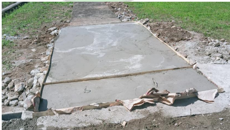
Gambar 4.20 Tutup Saluran yang Telah Kering
