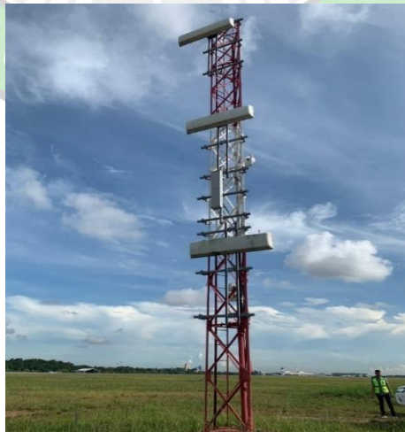
Gambar 2. 20 Antena Glide Path Sumber : Dokumentasi Penulis (2023)
