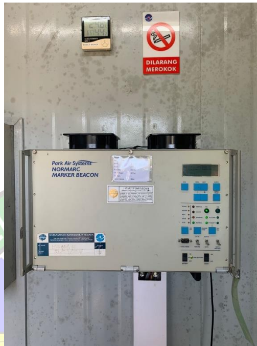
Gambar 2. 24 Transmitter Midle Marker Sumber : Dokumentasi Penulis (2023)
