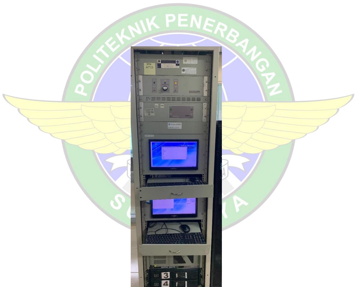
Gambar 3. 7 Alat Reproducer ATIS ELSA Sumber : Dokumentasi Penulis (2023)
