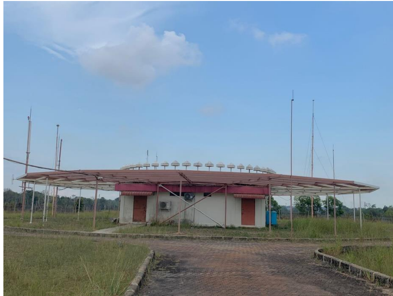
Gambar 2. 12 Antenna DVOR Sumber : Dokumentasi Penulis (2023)
