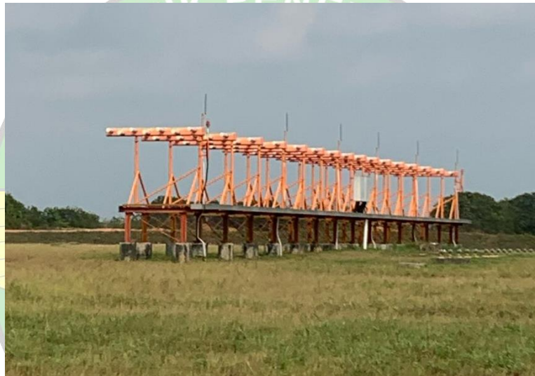
Gambar 2. 17 Antenna Localizer Sumber : Dokumentasi Penulis (2023)
