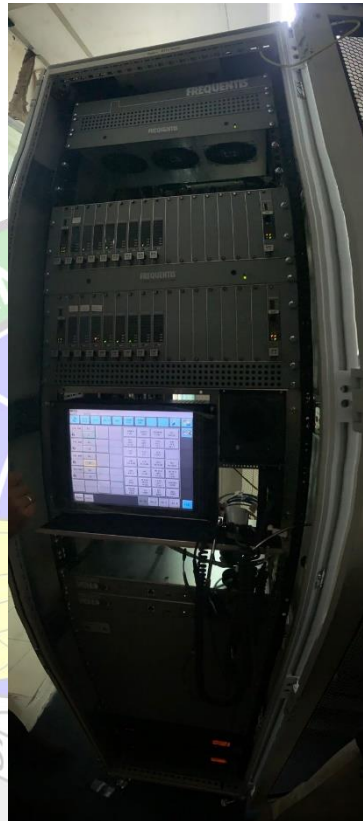
Gambar 2. 7 Monitor VCCS Frequentis Sumber : Dokumentasi Penulis (2023)
