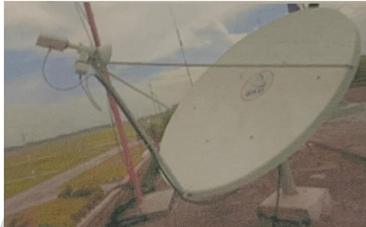
Gambar 2. 6 VSAT Lintas Arta di Perum LPPNPI Cabang Pembantu Batam Sumber : Dokumentasi Penulis (2023)
