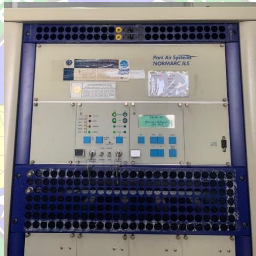
Gambar 2. 21 Transmitter Glide Path Sumber : Dokumentasi Penulis (2023)
