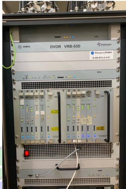
Gambar 2. 11 Modul DVOR Indra Co-Located DME Sumber : Dokumentasi Penulis (2023)
