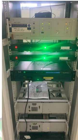
Gambar 3. 2 Transmitter ATIS Becker Sumber : Perum LPPNPI Cabang Pembantu Batam (2023)
