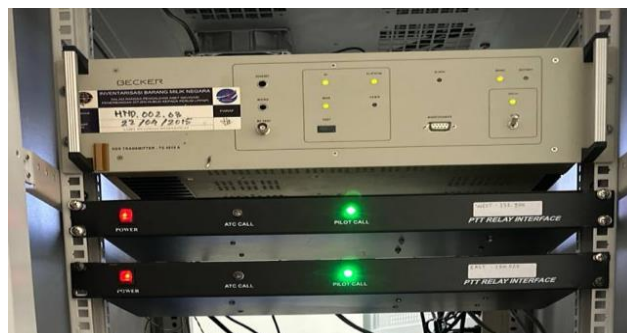
Gambar 3. 3 Transmitter ATIS Sumber: Dokumentasi Penulis, 2023
