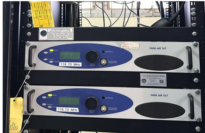
Gambar 3. 13 VHF A/G Primary TX Sumber: Dokumentasi Penulis, 2023
