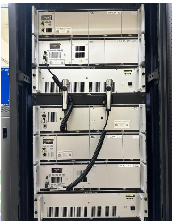
Gambar 3. 41 Peralatan Transceiver Jotron VHF-ER Sumber: Dokumentasi Penulis, 2023
