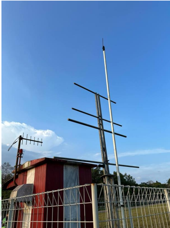
Gambar 3. 20 Antenna Middle Marker NORMARC Sumber: Dokumentasi Penulis, 2023
