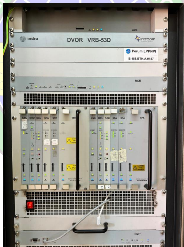
Gambar 3. 27 Peralatan DVOR INDRA INTERSCAN Sumber: Dokumentasi Penulis, 2023
