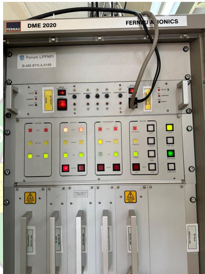
Gambar 3. 32 Peralatan DME FERNAU AVIONICS Sumber: Dokumentasi Penulis, 2023
