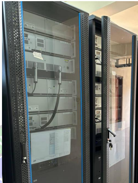
Gambar 3. 16 VHF A/G Transceiver JOTRON Sumber: Dokumentasi Penulis, 2023
