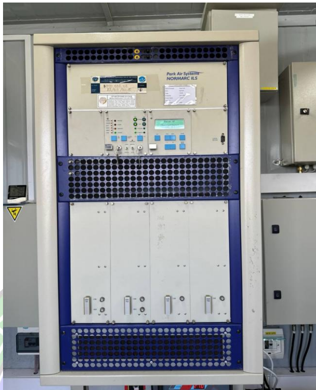
Gambar 3. 25 Peralatan Glide Slope NORMARC Sumber: Dokumentasi Penulis, 2023
