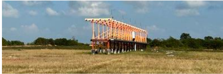
Gambar 3. 24 Antena Localizer NORMARC Sumber: Dokumentasi Penulis, 2023
