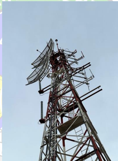
Gambar 3. 8 Antenna Radio Link Sumber: Dokumentasi Penulis, 2023
