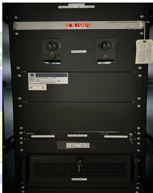
Gambar 3. 4 Peralatan Voice Recorder Sumber: Dokumentasi Penulis, 2023
