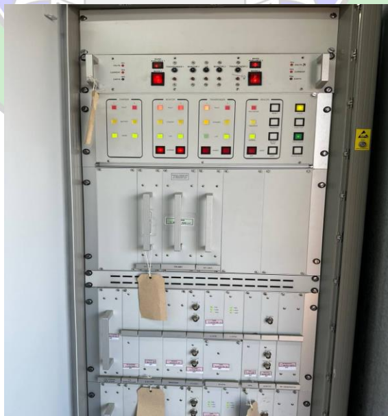
Gambar 3. 30 Peralatan T-DME FERN AU AVIONICS Sumber: Dokumentasi Penulis, 2023
