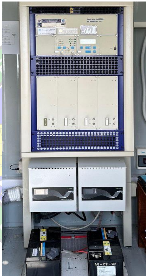
Gambar 3. 22 Peralatan Localizer NORMARC Sumber: Dokumentasi Penulis, 2023
