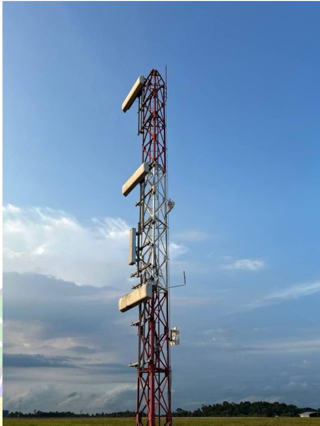
Gambar 3. 26 Antenna Glide Slope NORMARC Sumber: Dokumentasi Penulis, 2023
