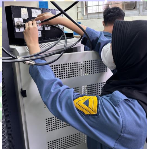
Gambar 3. 58 Pemasangan Cavity Filter pada Radio Jotron Sumber: Dokumentasi Penulis, 2023
