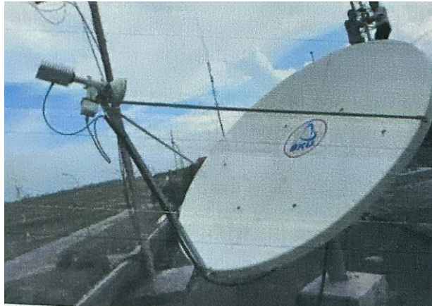
Gambar 3. 10 Antena VSAT Sumber: Dokumentasi Penulis, 2023
