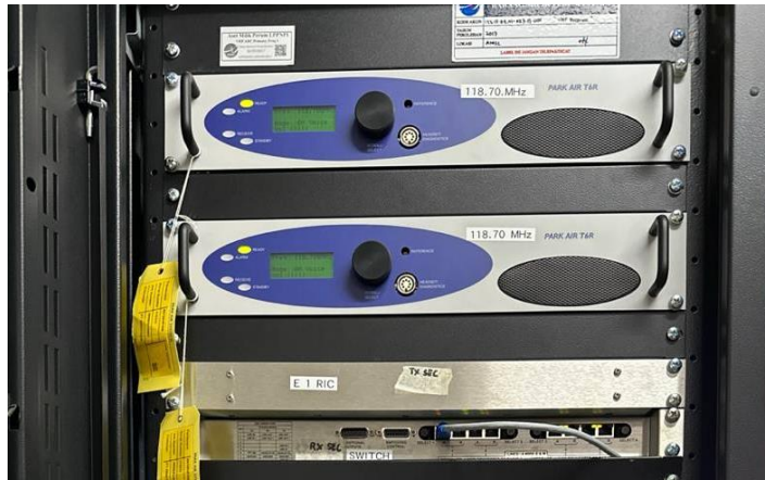
Gambar 3. 14 VHF A/G Primary RX Sumber: Dokumentasi Penulis, 2023
