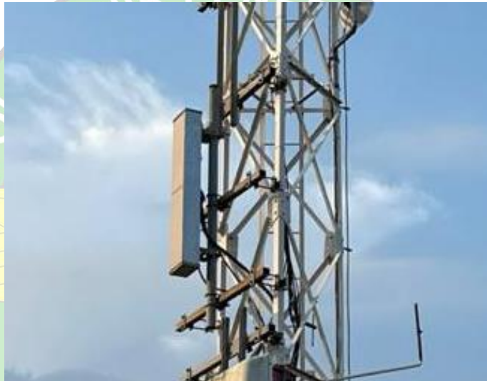
Gambar 3. 31 Antenna T-DME FERNAU AVIONICS Sumber: Dokumentasi Penulis, 2023
