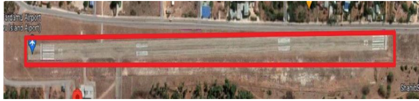
Gambar 4. 14 Runway Bnndar Udara Tardamu Sabu ( Sumber: Google Earth Akses 2023 )
