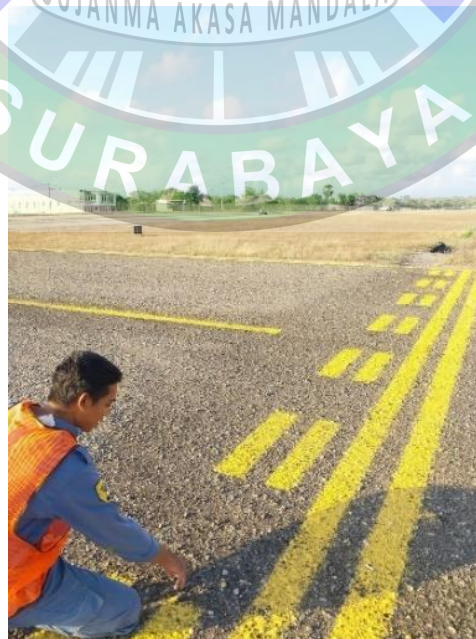
Gambar 4. 19 Inspeksi Taxiway ( Sumber: Dokumentasi Penulis, 2023 )
