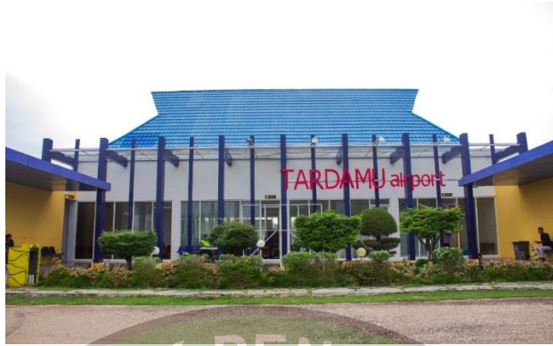
Gambar 4.1 Terminal Bandar Udara Tardamu Sabu ( Sumber: Dokumentasi Penulis ,2023 )
