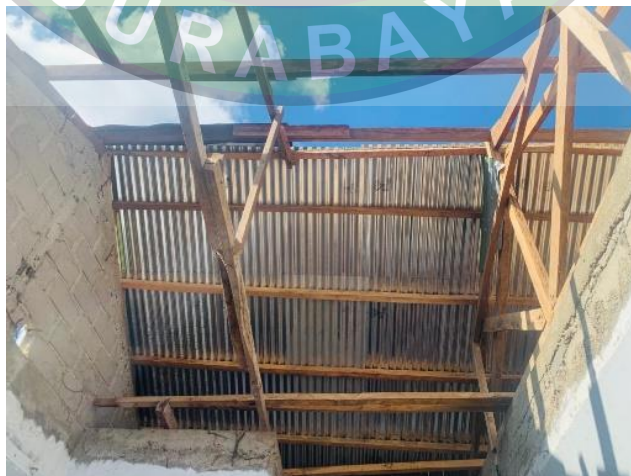
Gambar 4. 23 Pemasangan Atap Seng ( Sumber: Dokumentasi Penulis, 2023 )
