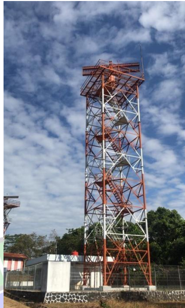
Gambar 3.28 Antenna Radar MSSR Mode S INDRA IRS 20/MPS 2 NA Sumber : Dokumentasi Penulis, 2023
