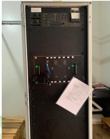
Gambar 3.24 Transmitter Glide Path Sumber : Dokumentasi Penulis, 2023
