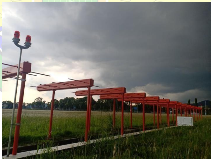
Gambar 3.23 Antenna Localizer Sumber : Dokumentasi Penulis, 2023
