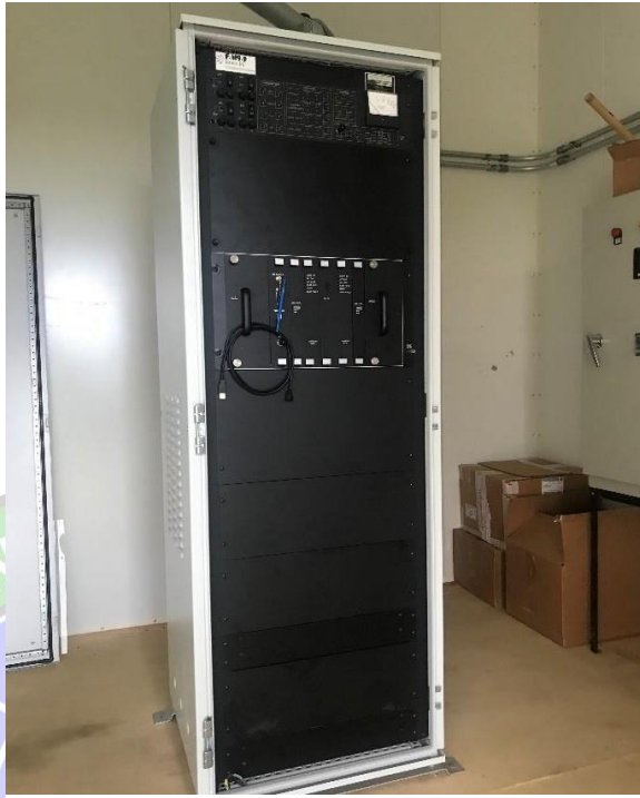
Gambar 3.22 Transmitter Localizer Sumber : Dokumentasi Penulis, 2023
