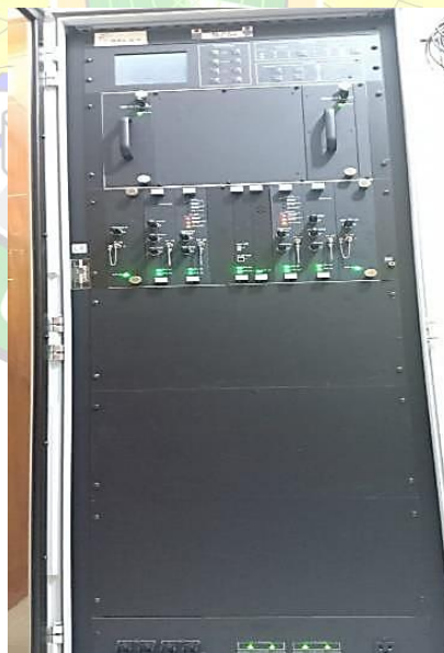
Gambar 3.16 DME collocated DVOR Sumber : Dokumentasi Penulis, 2023
