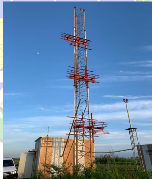
Gambar 3.25 Antenna Glide Path Sumber : Dokumentasi Penulis, 2023
