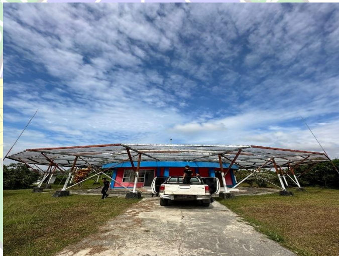
Gambar 3.13 Antena DVOR di Shelter DVOR Sumber: Dokumentasi Penulis, 2023
