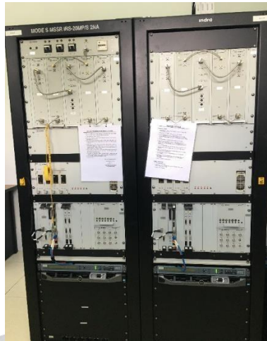
Gambar 3.27 Modul Radar MSSR Mode S INDRA IRS 20/MPS 2 NA Sumber : Dokumentasi Penulis, 2023
