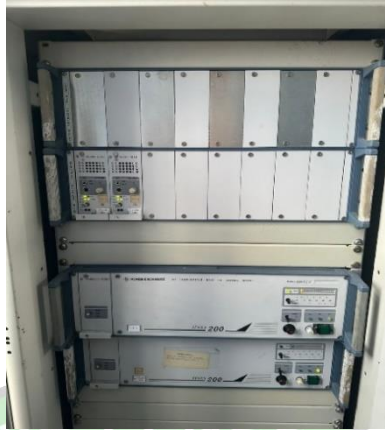
Gambar 3.7 Peralatan VHF A/G ADC Sumber : Dokumentasi Penulis,2023
