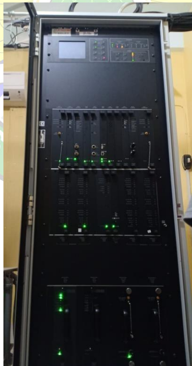
Gambar 3.15 Peralatan DVOR Sumber : Dokumentasi Penulis
