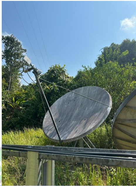
Gambar 3.3 Antenna VSAT Sumber : Dokumentasi Penulis,2023
