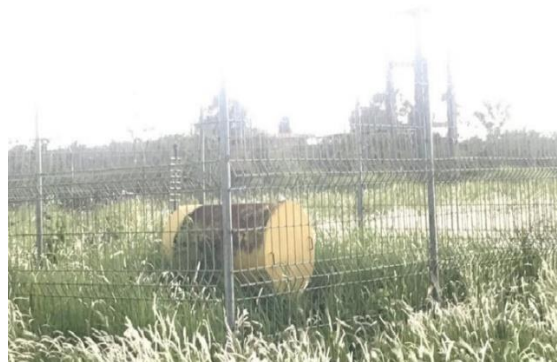
Gambar 3.19 Antenna Tuning Unit (ATU) NDB Sumber : Dokumentasi Penulis, 2023
