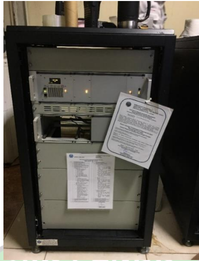
Gambar 3.6 Trasnmitter ATIS JOTRON Sumber : Dokumentasi Penulis,2023
