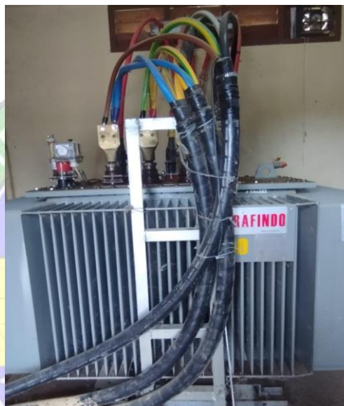
Gambar 4.5 Gambar Fisik Transformator Step-Up PH Sumber : Dokumentasi Pribadi
