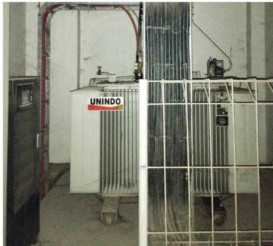
Gambar 4.7 Gambar Fisik Transformator Step – Down 2 Sumber : Dokumentasi Pribadi
