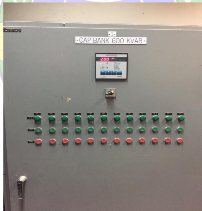
Gambar 4.10 Capacitor Bank Sumber : Dokumentasi Pribadi
