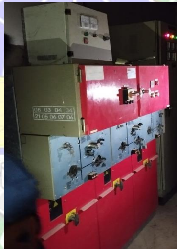
Gambar 4.9 Gambar Fisik Cubicle LVMDB
