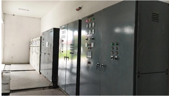
Gambar 3.4 Main Distribution Panel (MDP) Sumber : Dokumentasi Pribadi
