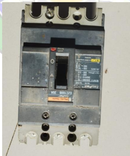
Gambar 3.2 Moulded Case Circuit Breaker (MCCB) nilai tetap Sumber : Dokumentasi Pribadi
