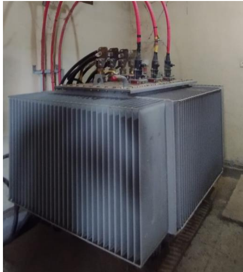
Gambar 4.6 Gambar Fisik Transformator Step - Down 1 Sumber : Dokumentasi Pribadi
