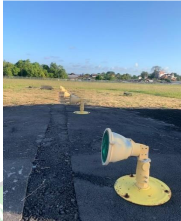
Gambar 2. 22 Threshold tipe Elevated Unidirectional Sumber : Dokumentasi Penulis
