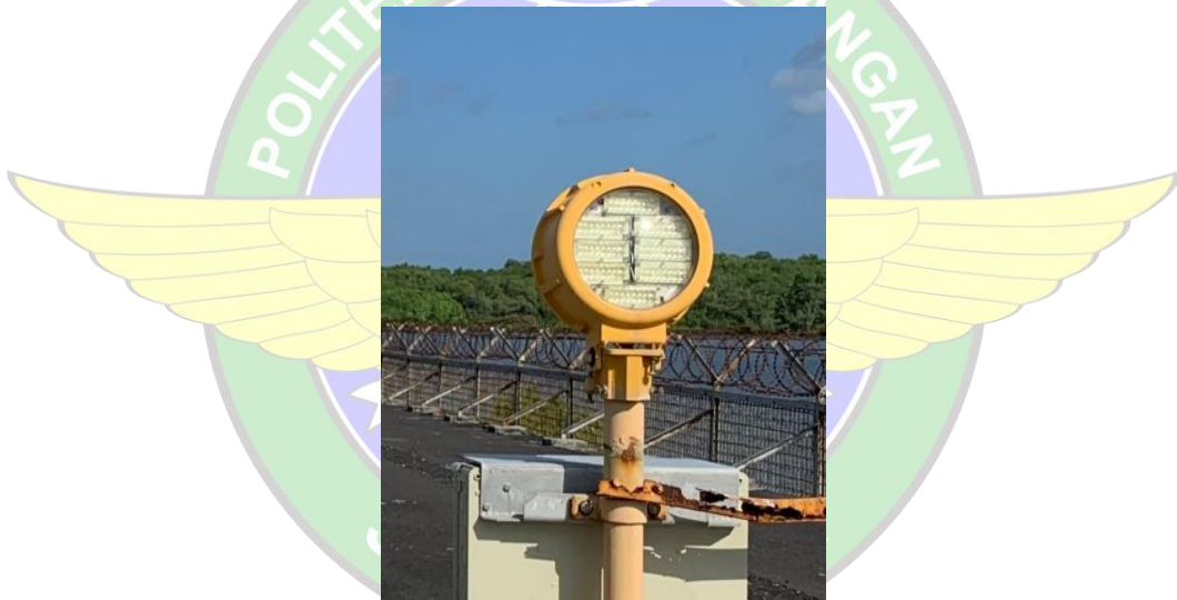
Gambar 2. 30 Sequence Flashing Light (SQFL) Sumber : Dokumentasi penulis
