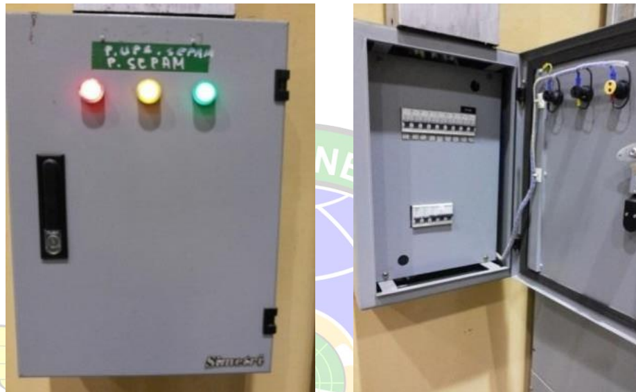
Gambar 2. 11 Panel Uninterruptable Power Supply (UPS) Sepam Sumber : Dokumentasi Penulis
