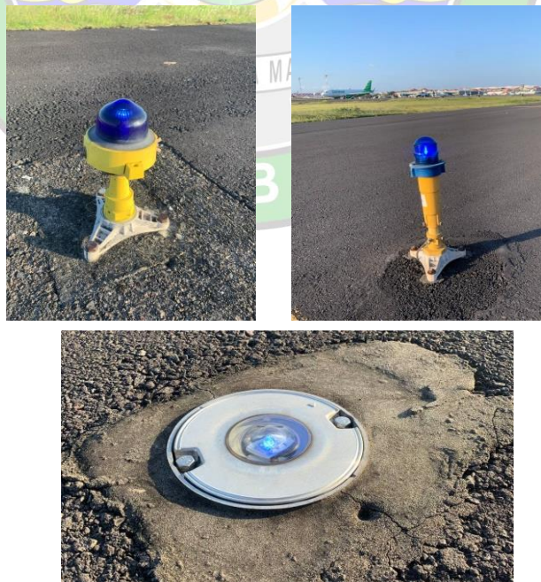
Gambar 2. 27 Lampu Taxiway Inset dan Lampu Taxiway Elevated Sumber : Dokumentasi Penulis
