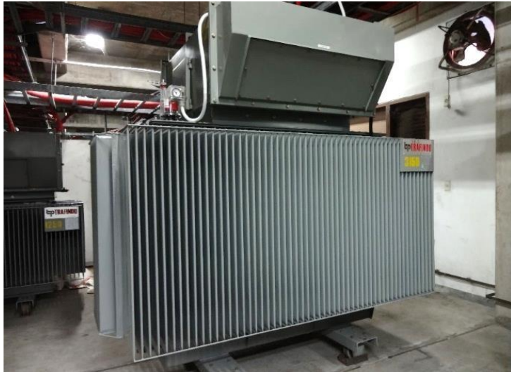
Gambar 2. 7 Trafo Trafindo 3150 kVA
