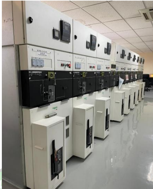
Gambar 2. 4 Panel TM MPH 2 Sumber : Dokumentasi Penulis
