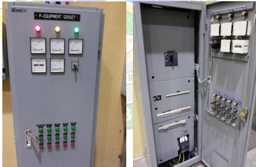
Gambar 2. 10 Panel Equipment Genset Sumber : Dokumentasi Penulis
