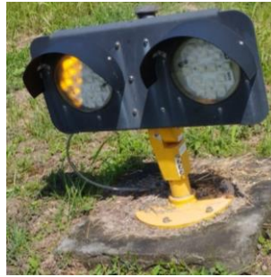
Gambar 2. 38 Runway Guard Light (RGL) Sumber : Dokumentasi Penulis
