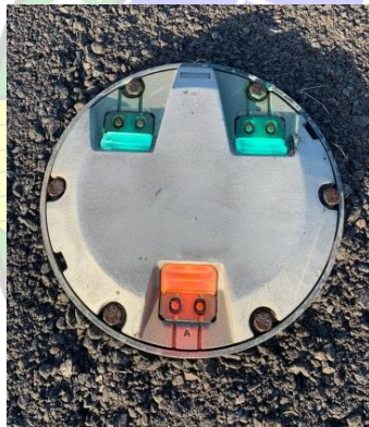
Gambar 2. 23 Threshold Light Inset dan Runway End Sumber : Dokumentasi Penulis
