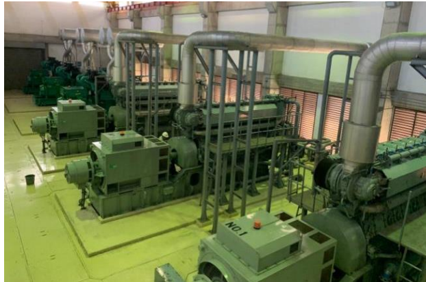
Gambar 2. 2 Generator Set Sumber :Dokumentasi Penulis
