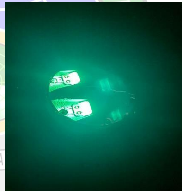
Gambar 2. 23 Threshold Light Inset dan Runway End Sumber : Dokumentasi Penulis
