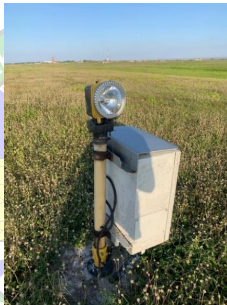
Gambar 2. 32 Runway Threshold Identification Light Sumber : Dokumentasi penulis
