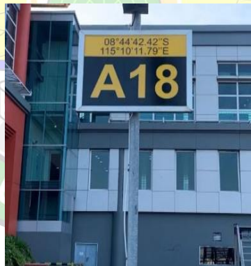
Gambar 2. 39 Spot Number Light (SNL) Sumber : Dokumentasi Penulis
