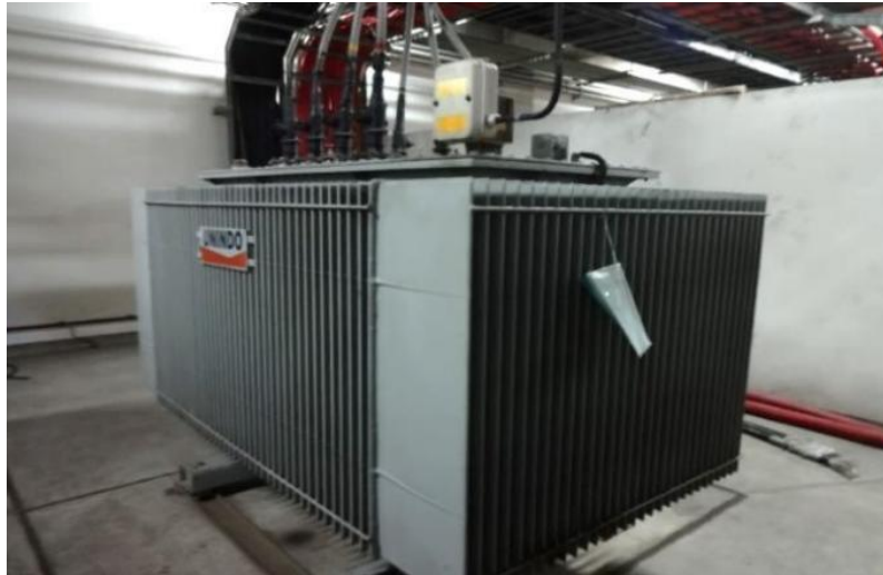
Gambar 2. 5 Trafo Unindo 2000 kVA
