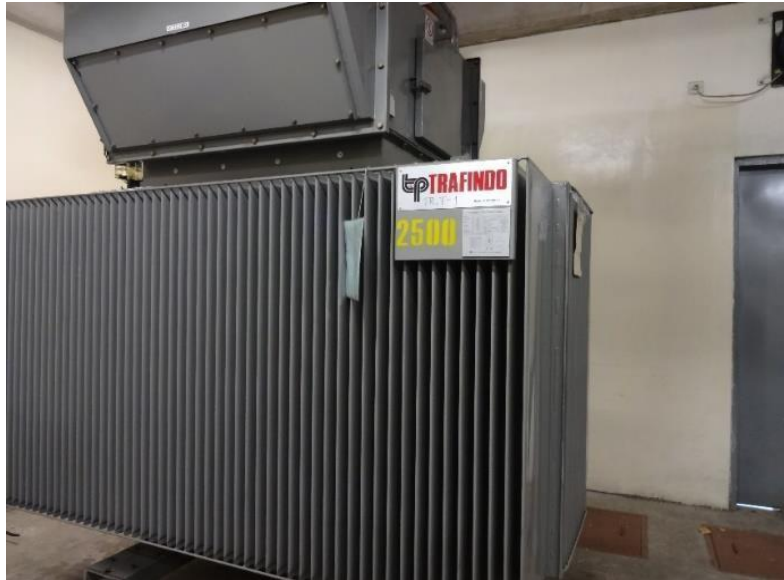
Gambar 2. 6 Trafo Trafindo 2500 kVA
