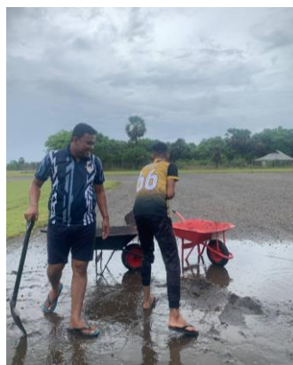
Gambar 4.21 Mengumpulkan agregat dan pasir menggunakan sekop ke gerobak arco (Sumber: Dokumentasi Pribadi, 2023)
