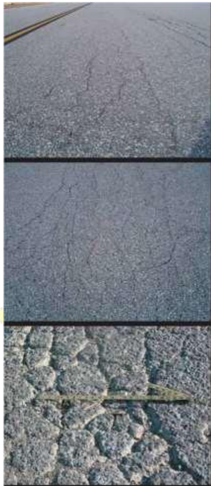
Gambar 3.4 Retak kulit buaya (Sumber: KP 94 tahun 2015)
