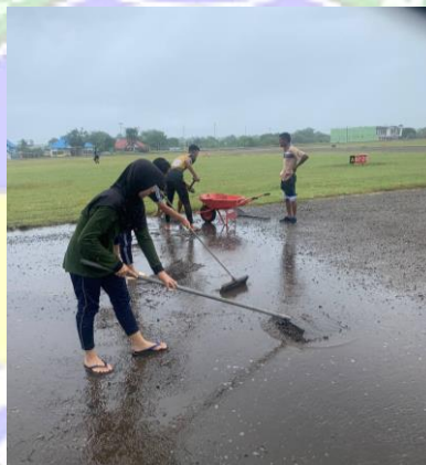
Gambar 4.20 Pengerukan butiran agregat (Sumber: Dokumentasi Pribadi, 2023)
