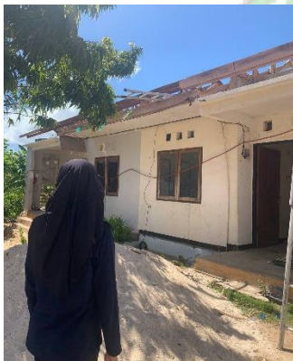
Monitoring renovasi rumah dinas
