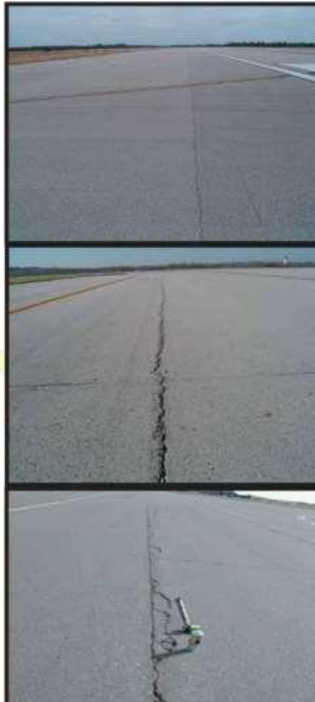
Gambar 3.5 Retak reflektif sambungan (Sumber: KP 94 tahun 2015)
