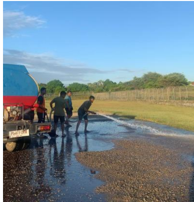
Gambar 4.19 Penyiraman Apron (Sumber: Dokumentasi Pribadi, 2023)
