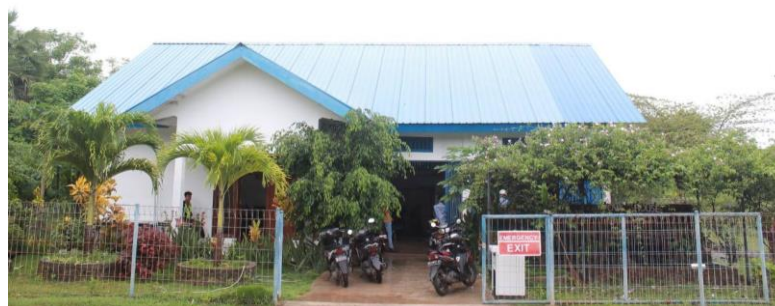
Gambar 4.10 Gedung Power House (Sumber: Dokumentasi Pribadi, 2023)
