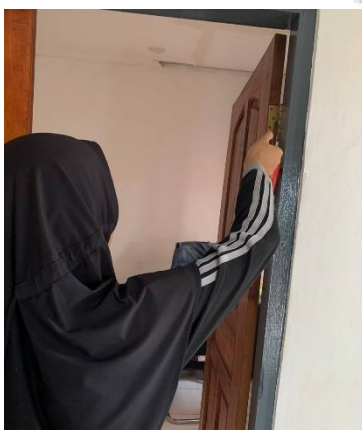
Pemberian oli pada engsel pintu
