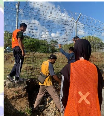
Perbaikan pagar perimeter
