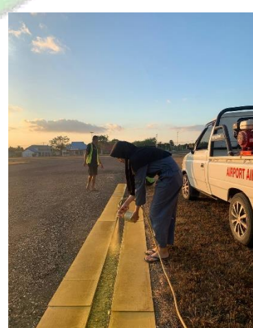
Pengecatan marka Apron
