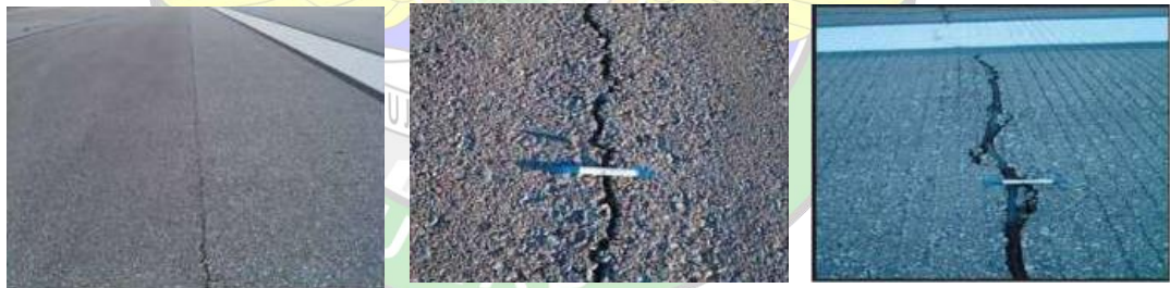
Gambar 3.1 Retak memanjang dan melintang (Sumber: KP 94 Tahun 2015)
