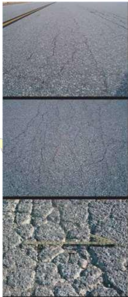
Gambar 3.2 Retak Kulit Buaya (Sumber: KP 94 Tahun 2015)
