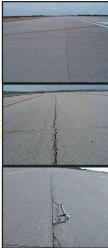
Gambar 3.3 Retak Reflektif Sambungan (Sumber: KP 94 Tahun 2015)
