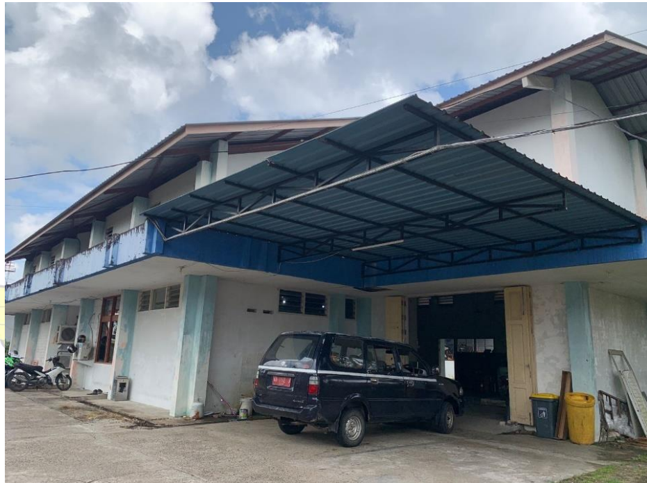
Gambar 4.10 Gedung Power House (Sumber: Dokumentasi Pribadi, 2024)
