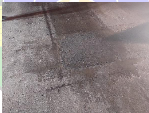
Gambar 4.27 Pekerjaan patching selesai (Sumber: Dokumentasi pribadi, 2023)
