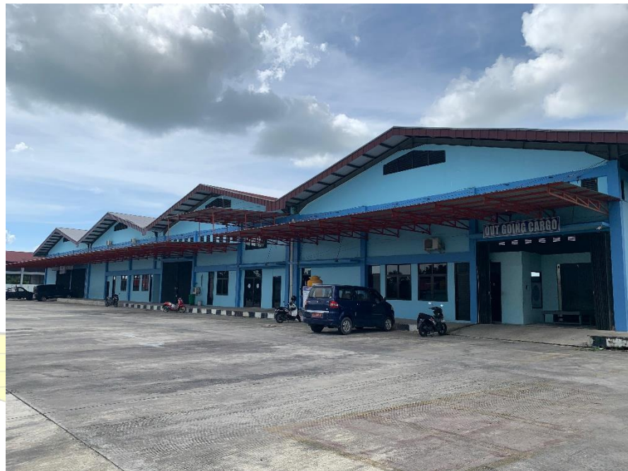
Gambar 4.13 Terminal kargo (Sumber: Dokumentasi Pribadi, 2024)
