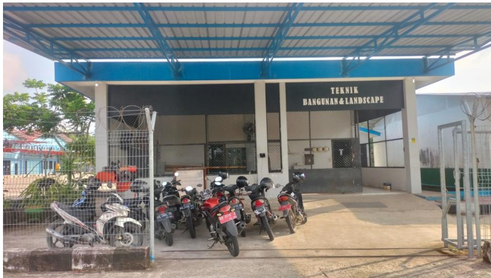
Gambar 4.11 Gedung bangunan & landscape (Sumber: Dokumentasi Pribadi, 2024)
