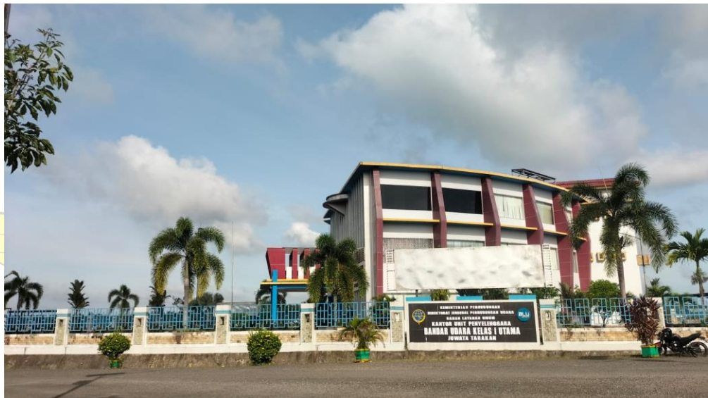
Gambar 4.7 Gedung administrasi (Sumber: Dokumentasi Pribadi, 2024)
