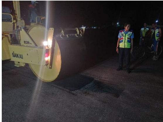
Gambar 4.26 Pemasangan dengan tandem roller (Sumber: Dokumentasi pribadi, 2023)
