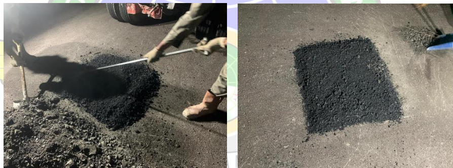
Gambar 4.25 Perataan hotmix (Sumber: Dokumentasi pribadi, 2023)
