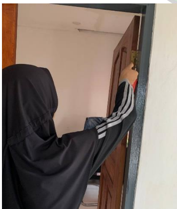
Pemberian oli pada engsel pintu
