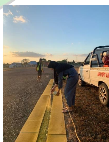
Pengecatan marka Apron
