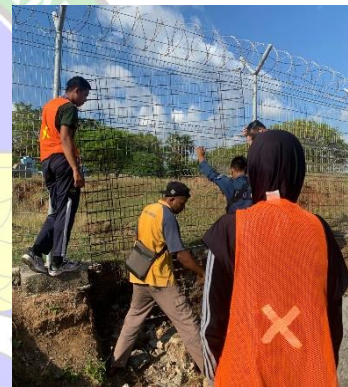
Perbaikan pagar perimeter
