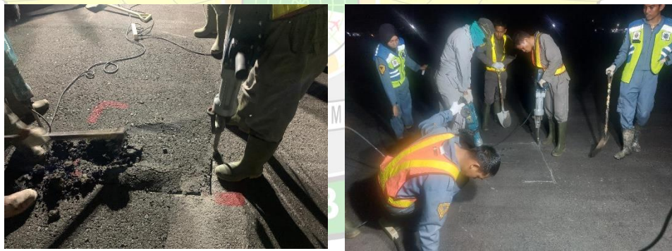
Gambar 4.21 Proses pembongkaran (Sumber: Dokumentasi pribadi, 2023)
