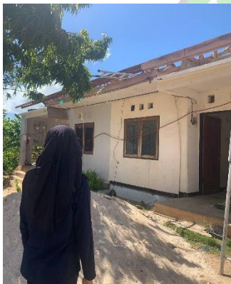
Monitoring renovasi rumah dinas
