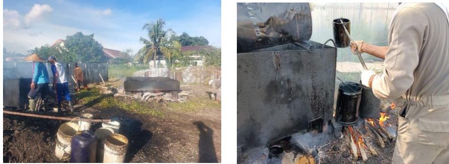
Gambar 4.20 Pembuatan tack coat (Sumber: Dokumentasi pribadi, 2023)
