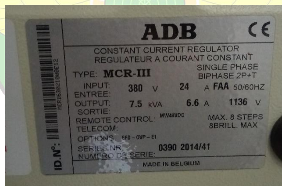
Gambar 2.11 CCR Taxiway Edge Light Rangkaian A dan B
