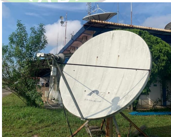
Gambar 3. 4 Peralatan VSAT Lintas Arta Sumber : Dokumentasi Penulis (2023)
