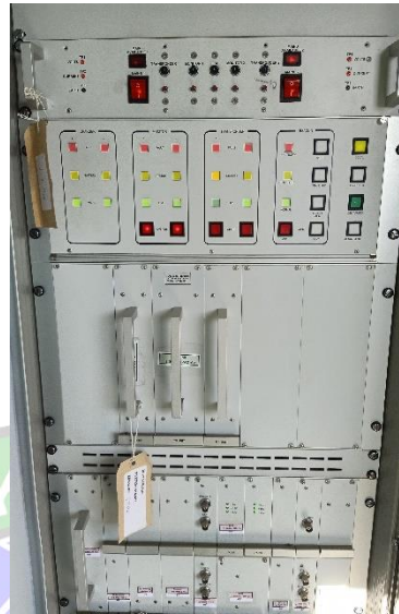
Gambar 3. 16 Peralatan T-DME Sumber : Dokumentasi Penulis (2023)
