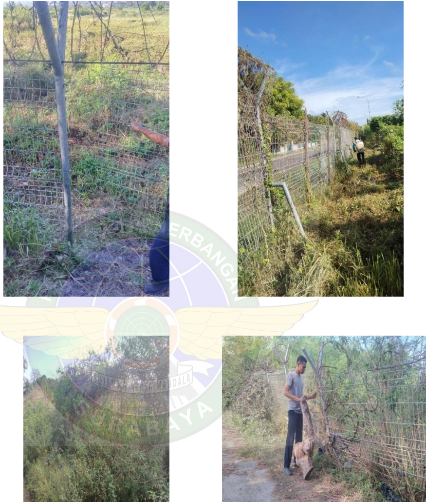
Gambar 4. 13 Kerusakan pagar perimeter Sumber : Dokumentasi Penulis, 2023
