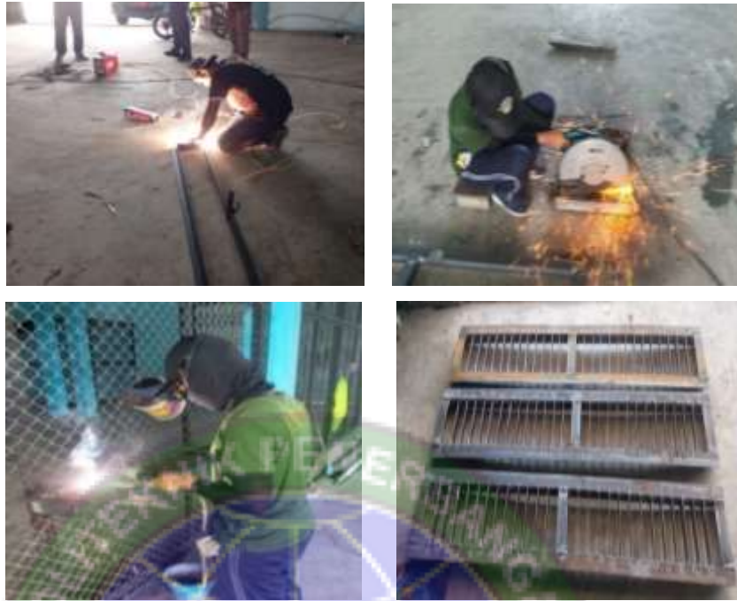
Gambar 4.8 Proses pekerjaan pembuatan grating drainage Sumber : Dokumentasi pribadi, 2023
