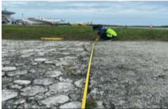
Gambar 4.11 Pengukuran GSE road Sumber : Dokumentasi pribadi, 2024
