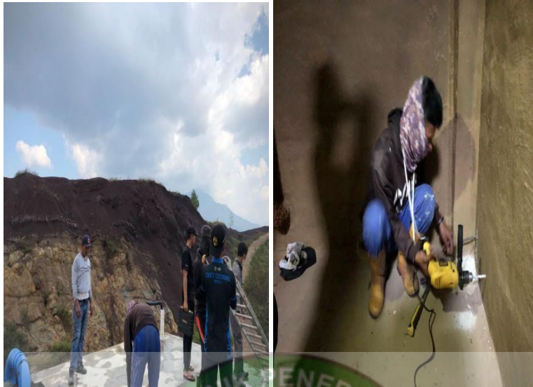
Lampiran 5 Pekerjaan Pemasangan Tulangan Besi pada Tandon Air Beton
