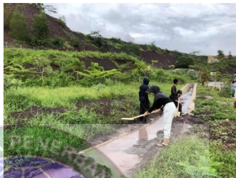
Gambar 4.15 Pembersihan Genangan Air pada Drainase
