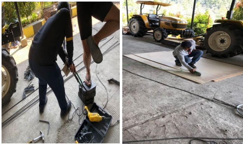
Lampiran 3 Pekerjaan Pembengkokan Besi
