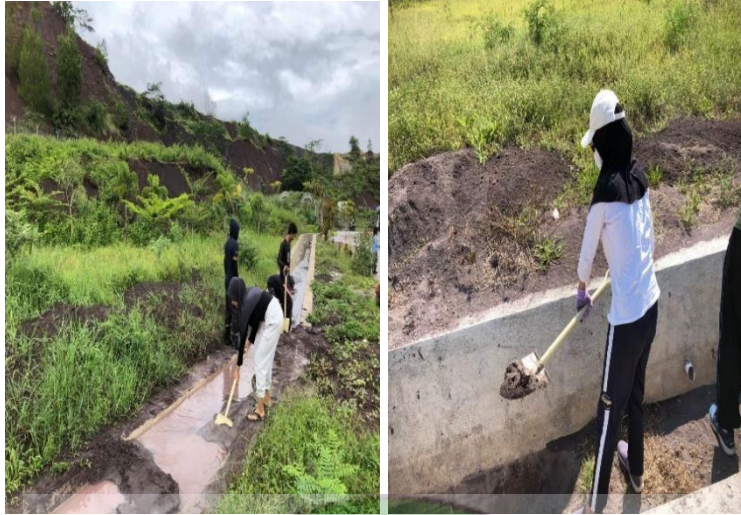
Lampiran 1 Pekerjaan pembersihan Drainase Sisi Udara
