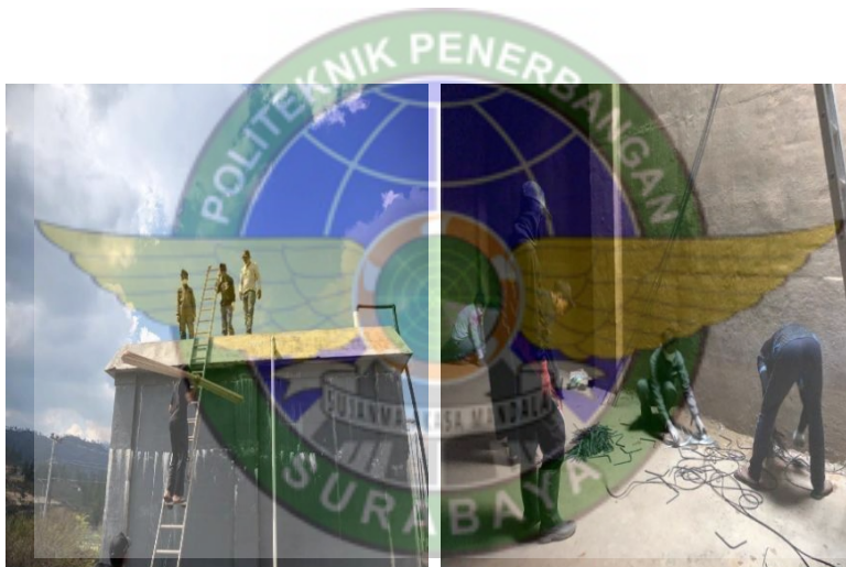
Lampiran 4 Pekerjaan pemasangan Besi pada Tandon Air Beton
