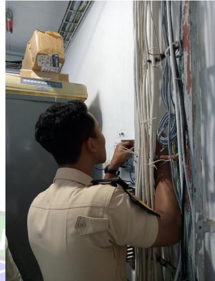
Mengganti MCB UPS
