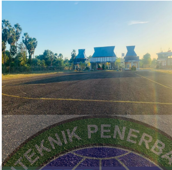
Gambar 4. 25 Dokumentasi pasca pengecatan marka apron (Sumber : Olahan penulis, 2023)
