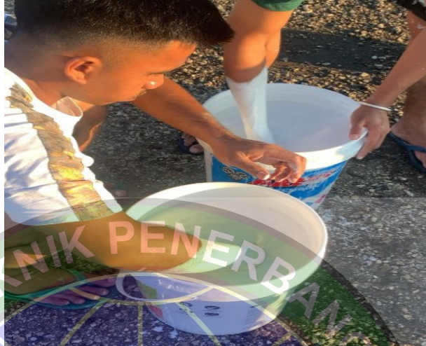
Gambar 4. 19 Proses pencampuran cat (Sumber : olahan penulis, 2023)
