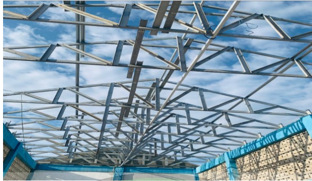
Gambar 4. 30 Pemasangan atap kuda – kuda (Sumber : Olahan penulis, 2023)
